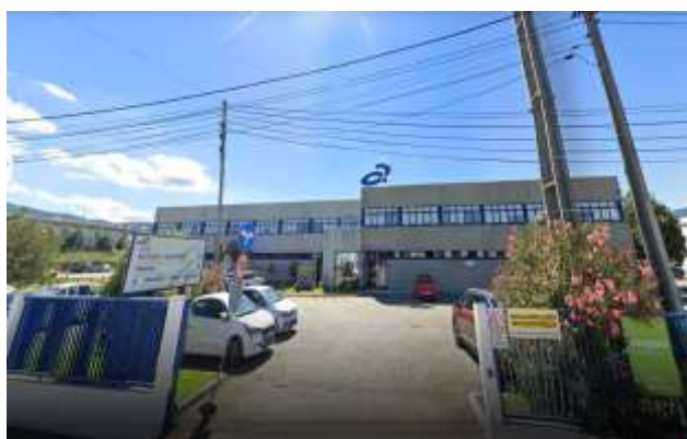
Figura 5: Exterior do edifício LUS1 (montagem e expedição)
