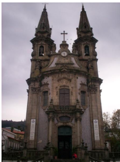
Fig. 1. Fachada , Igreja de Nossa Senhora da Consolação e Santos Passos,
