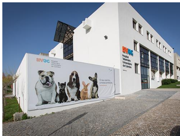
Figura 10 - Fachada do HVUC
