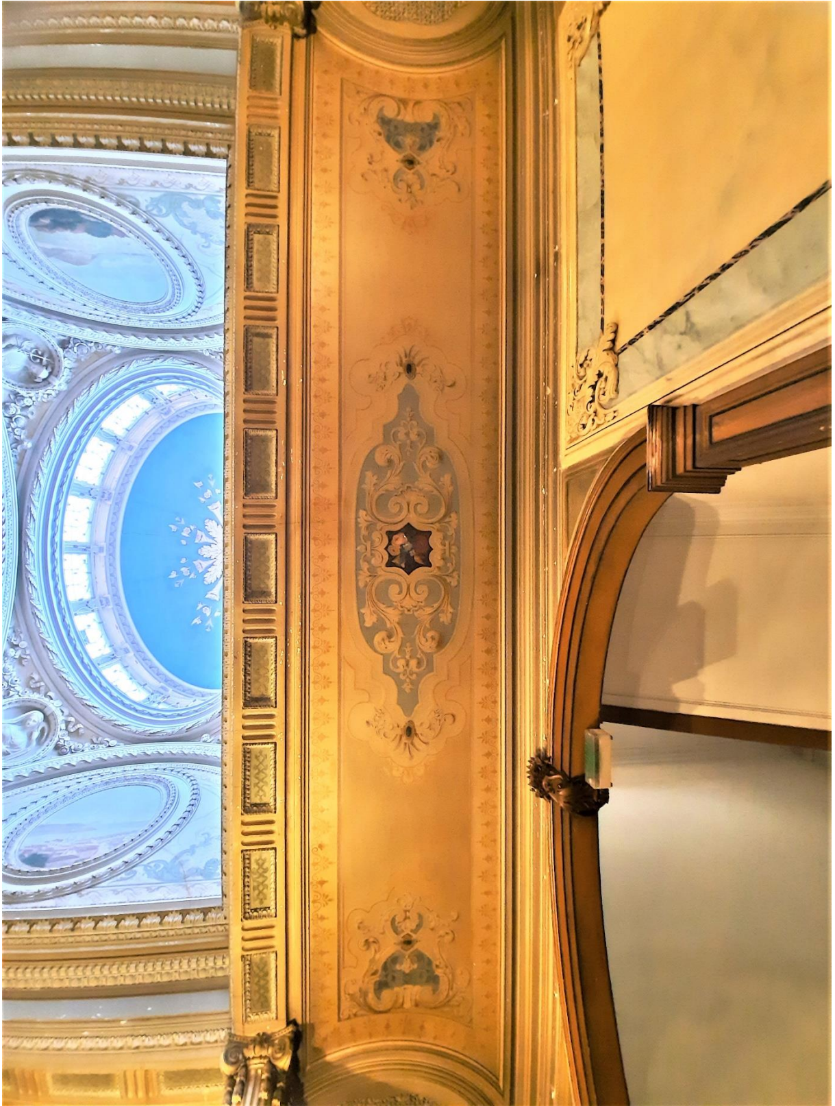
Figura 215: Teto do corredor mais a este da galeria do 2º piso do Palacete Silva Monteiro antes da intervenção (à luz dos candeeiros da galeria). Rebeca Rodrigues ©
