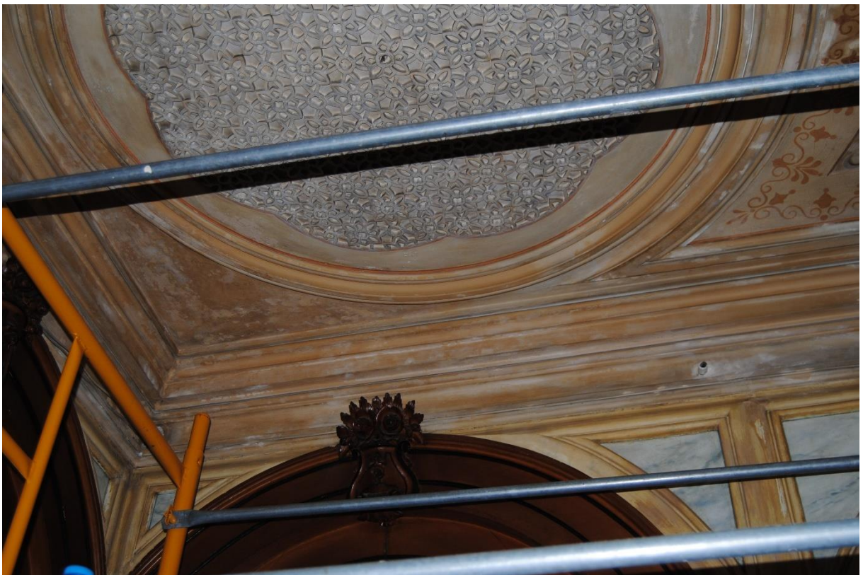
Figura 162: Resultado da consolidação e preenchimento do friso e teto. Rebeca Rodrigues ©
