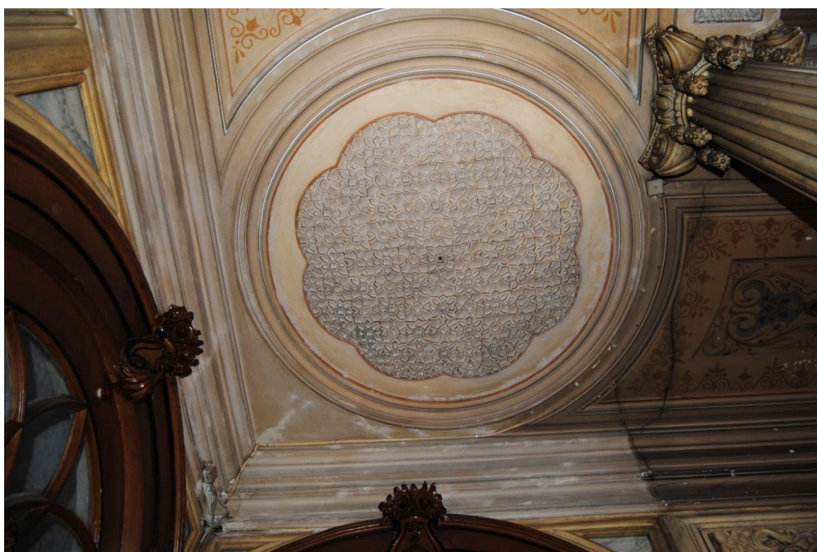
Figura 166: Consolidação e preenchimento do friso, teto e florão, com remoção da calha de suporte de frisos elétricos. Rebeca Rodrigues ©
