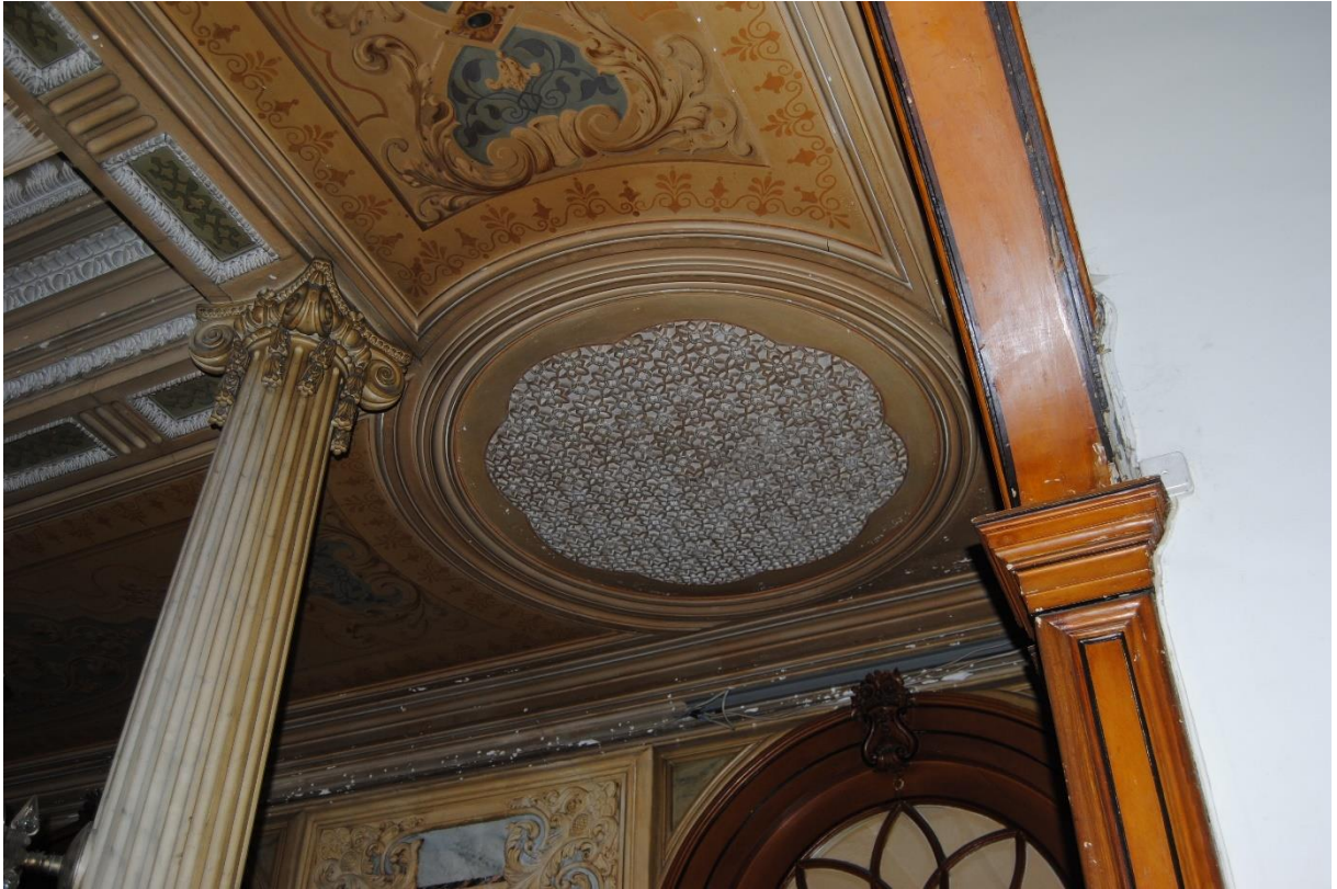
Figura 204: Zona mais a norte, antes da intervenção. Rebeca Rodrigues ©
