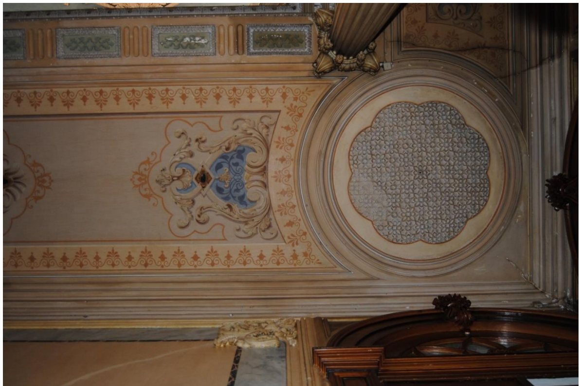
Figura 144: Limpeza química da pintura policromada, frisos e florão da zona mais a sul do teto. Rebeca Rodrigues ©
