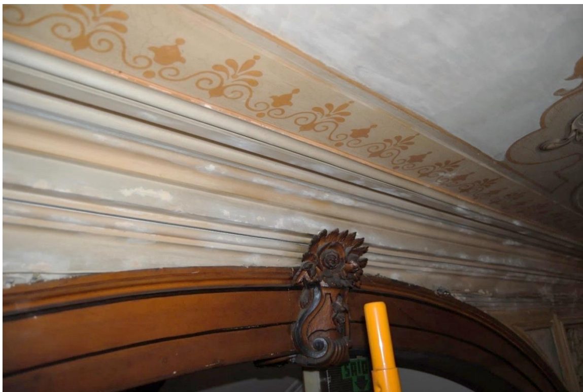
Figura 165: Preenchimento e nivelamento do friso. Rebeca Rodrigues ©
