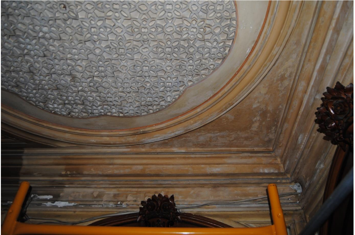
Figura 161: Consolidação e preenchimento do friso, teto e florão, com remoção da calha de suporte de frisos elétricos. Rebeca Rodrigues ©
