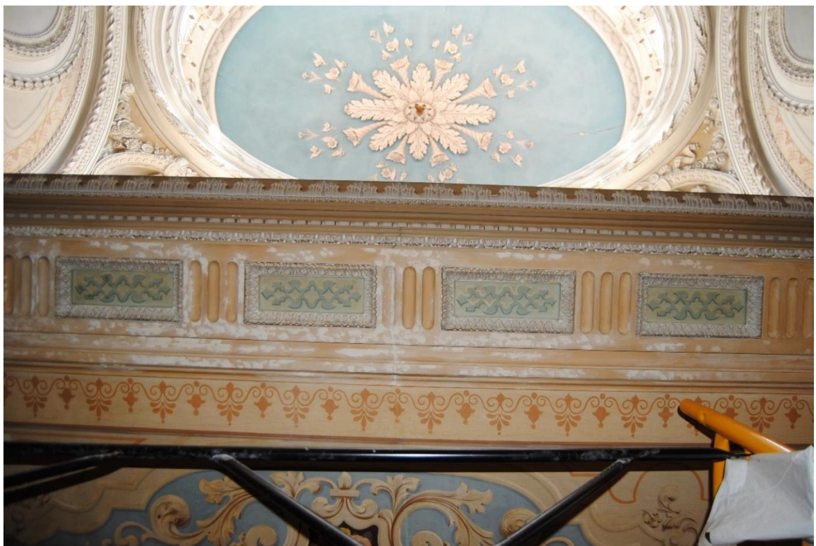
Figura 164: Consolidação, preenchimento e nivelamento do friso do interior do teto. Rebeca Rodrigues ©
