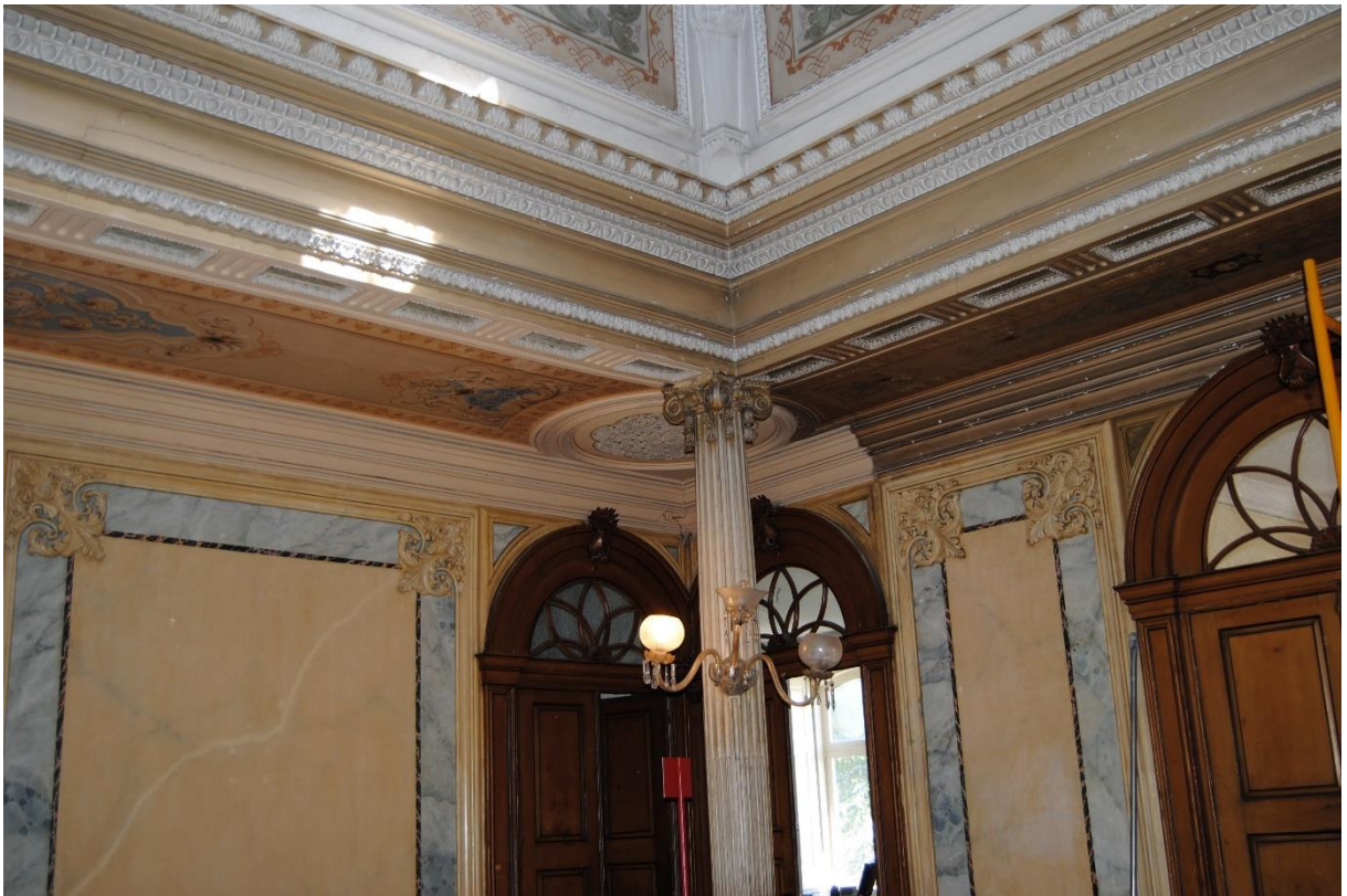
Figura 214: Antes e depois da intervenção na zona sul. Rebeca Rodrigues ©
