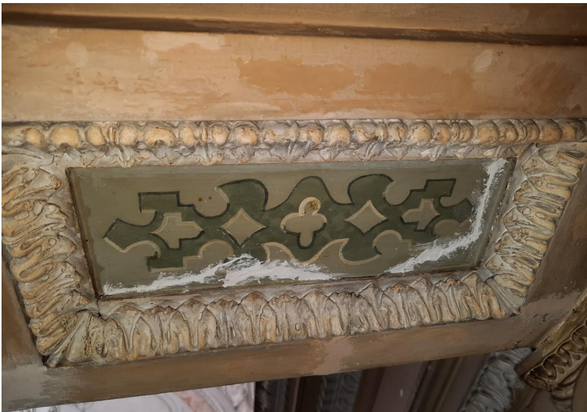
Figura 160: Antes e o depois da aplicação de massas de nivelamento no friso e pintura verde mais a norte. Rebeca Rodrigues ©
