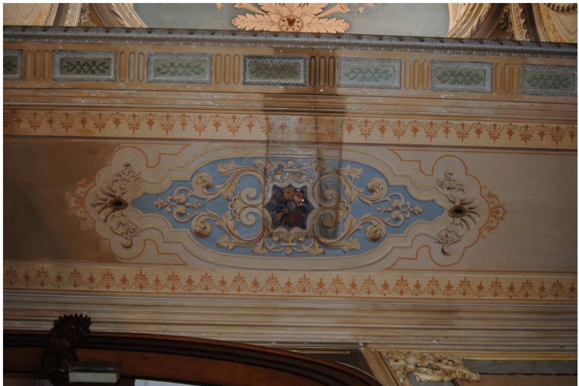
Figura 138: Limpeza química com janela de sujidade superficial ao centro. Rebeca Rodrigues ©
