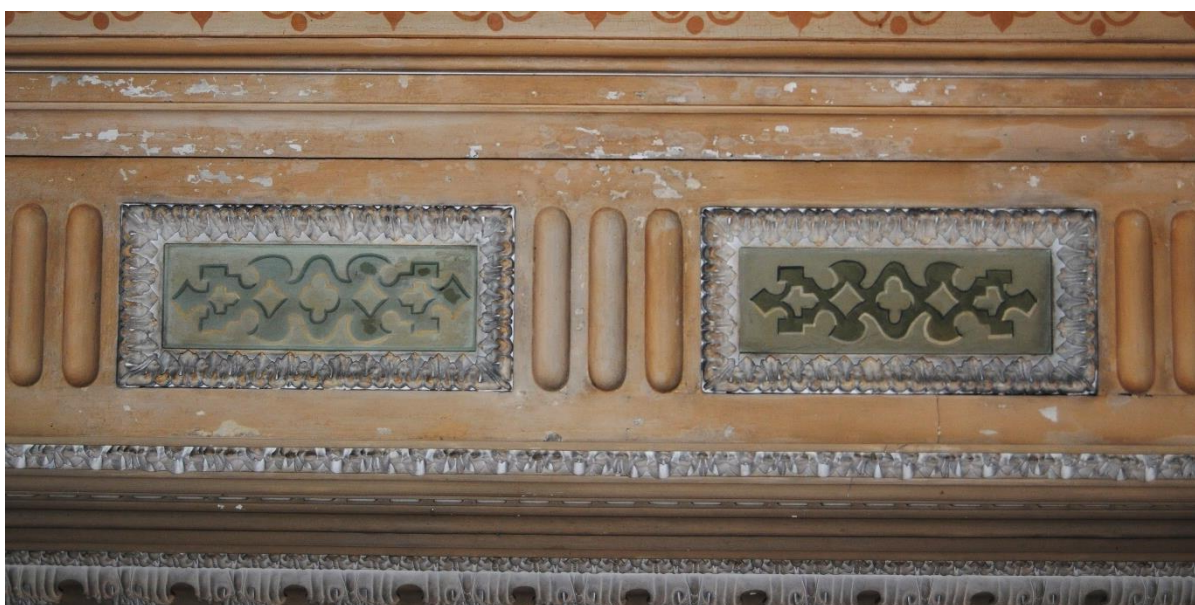
Figura 114: Comparação entre pintura original (esquerda) e pintura repintada (direita). Rebeca Rodrigues ©
