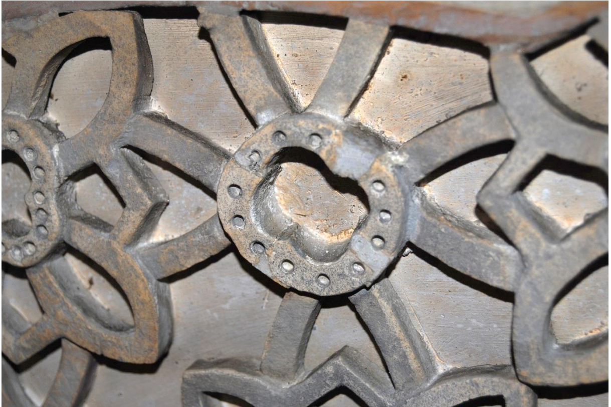
Figura 70: Pormenor das uniões entre as peças que compõe o florão. (Rebeca Rodrigues ©)
