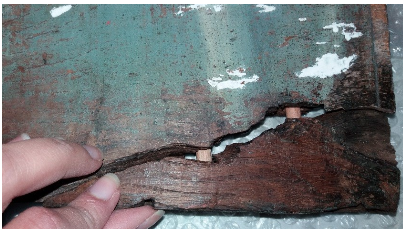
Figura Ap-V 5. Fixação do fragmento com cavilhas.
