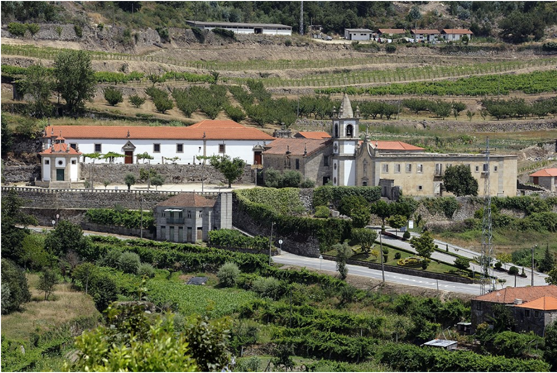
Figura An-I 1. Vista geral do exterior.
