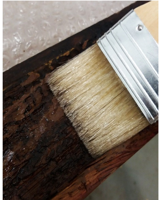
Figura Ap-V 32. Consolidação a trincha.
