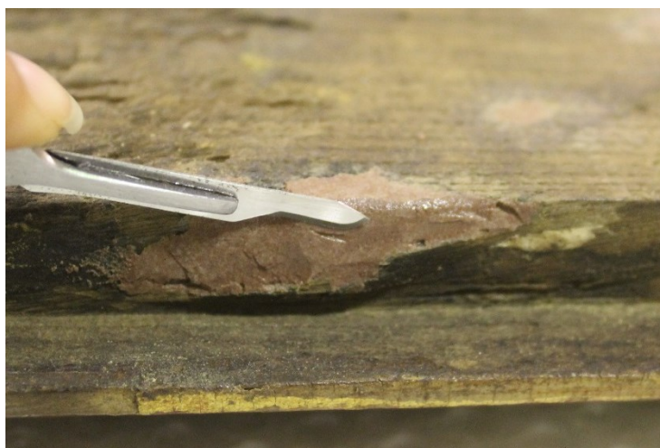
Figura Ap-V 35. Nivelamento da massa epóxida com bisturi.
