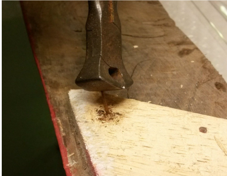
Figura Ap-V 24. Remoção dos elementos metálicos.
