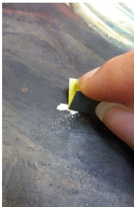
Figura Ap-V 19. Nivelamento da massa de preenchimento.
