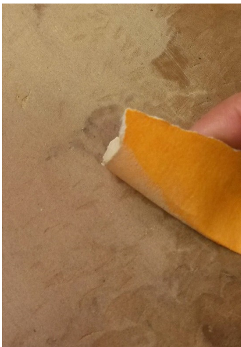
Figura Ap-V 8. Nivelamento da massa epóxida com lixa.
