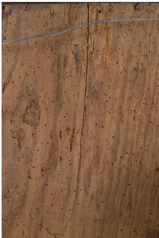
Figura Ap-IV 3. Fissura, verso do painel.
