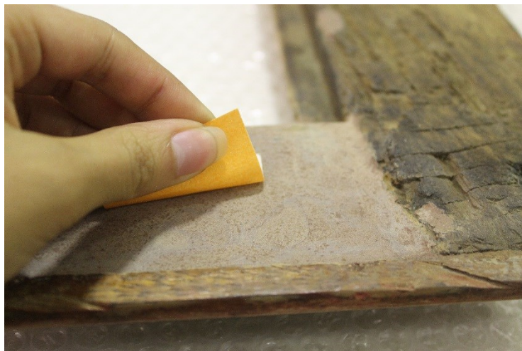
Figura Ap-V 34. Nivelamento da massa epóxida com lixa.
