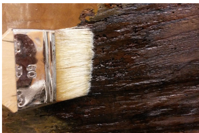
Figura Ap-V 12. Consolidação a trincha.
