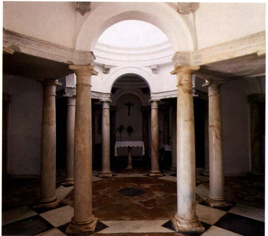
Interior da igreja do Convento do Bom Jesus do Valverde, Évora.
