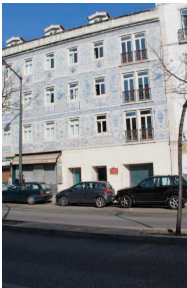
Fotografia 7 - Hotel ainda por abrir (Villa Santa Ana)
