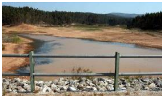
Figura 5.5 – Albufeira da Sobrena, vista do paredão (Fonte: www.oesteonline.pt )
