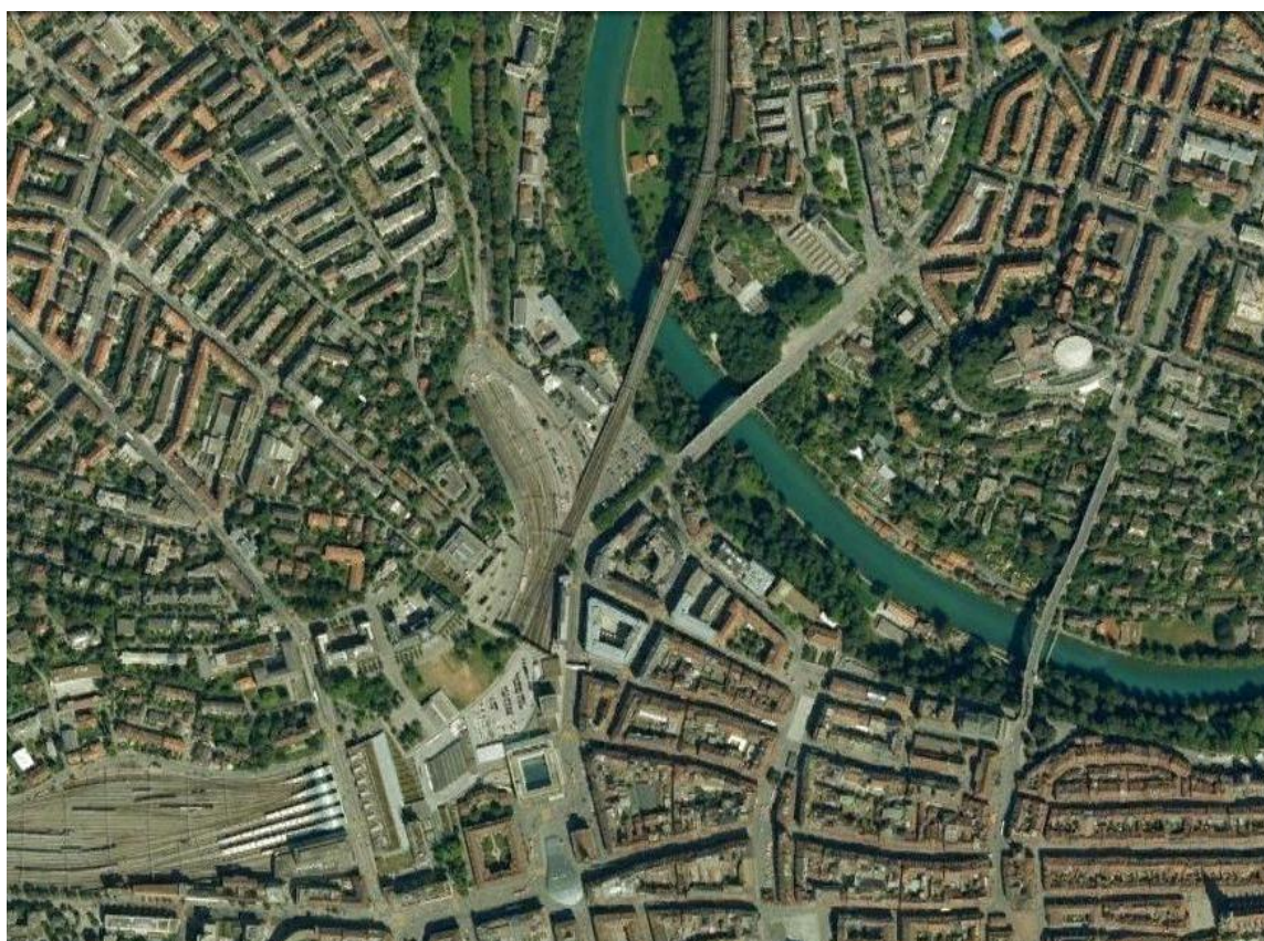
Figura 12: Vista aérea da zona de intervenção. Fonte: Schindler, 2012e.
