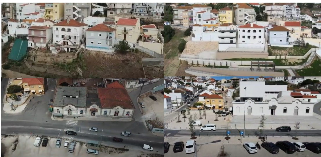
Figura 116 Registo fotográfico de antes e depois das intervenções em edifício reabilitado para habitação social e Matadouro Municipal - Centro de Arte e Criatividade. Câmara Municipal de Torres Vedras.
