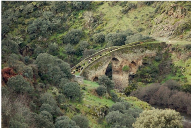
Figura 199 Ponte românica. Fotografia de Paulo Rodrigues.
