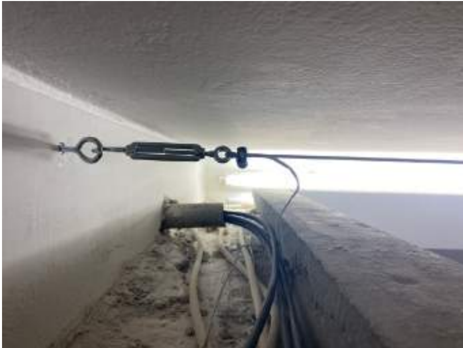
Figura 11: Pormenor de montagem dos arames (buchas, camarões e esticadores) onde se estenderiam as cortinas posteriormente.
