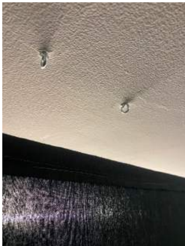
Figura 22: Fixação dos camarões e buchas no tecto, a partir dos quais as peças de barro foram suspensas.
