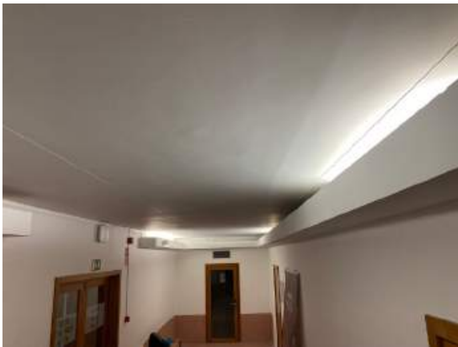
Figura 12: Vista superior da sala, onde é possível ver os dois arames, suportes para as cortinas de flanela, já montados e esticados.
