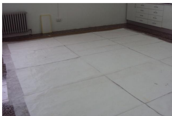
Fot. nº 115 – Colocação de papel reemay.
