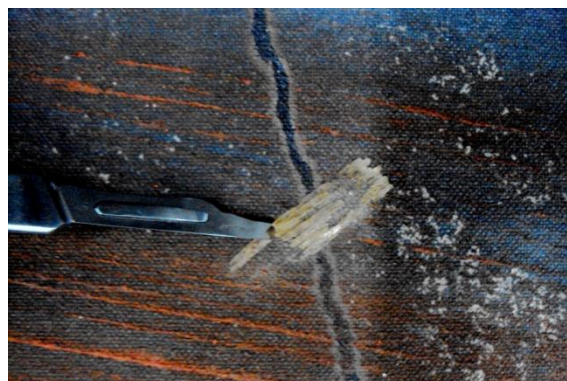
Fot. nº 91 - processo de remoção de sujidade incrustada 2
