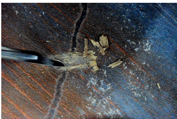
Fot. nº 92 -Processo de remoção de sujidade incrustada 3
