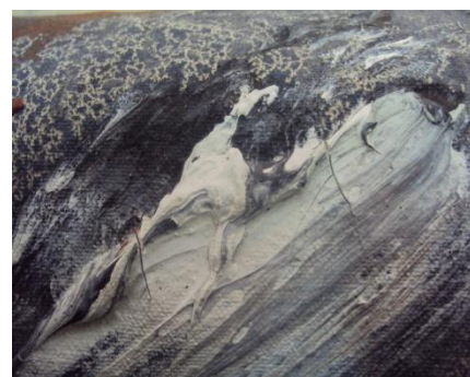
Fot. nº 41 – Fissuras, pormenor.
