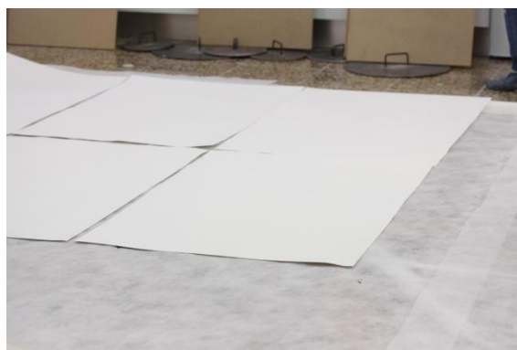
Fot. nº 117 – Colocação da camada anterior (efeito sandwich).
