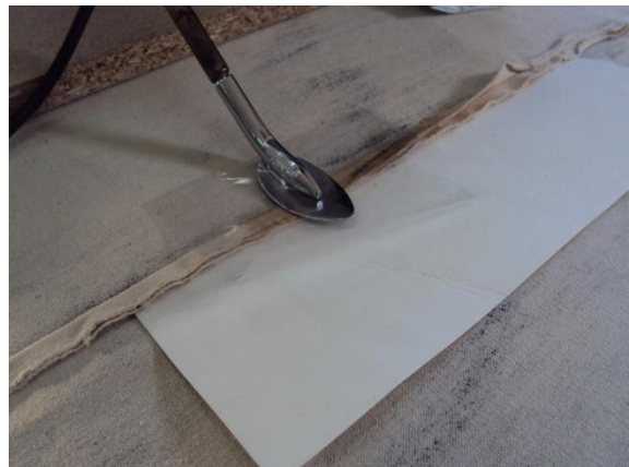
Fot. n° 98 – Planificação pontual com espátula térmica.
