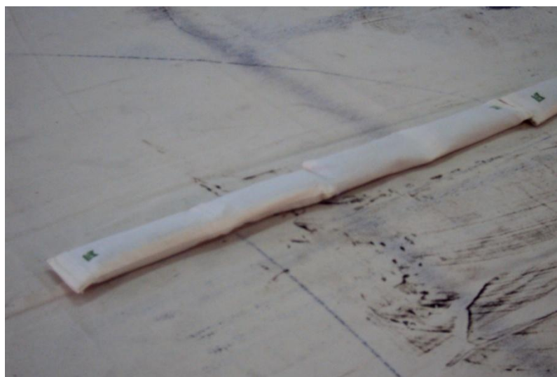
Fot. n° 99 – Colocação de pesos por cima da área planificada.
