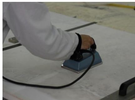
Fot. nº 60 – Colocação da banda de uma das bandas de reforço.
