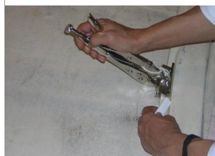
Fot. nº 73 – Colocação de calhas em PVC.
