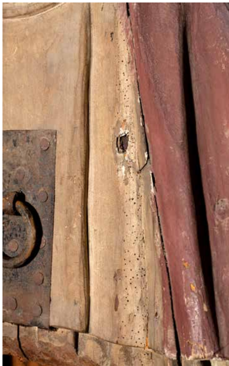
Pormenor do reverso da imagem de São Basílio, antes da intervenção, destacando-se os orifícios que resultaram da infestação e os elementos metálicos oxidados (2021, Centro de Conservação e Restauro – UCP©, fotografia de Sérgio Rolando).
