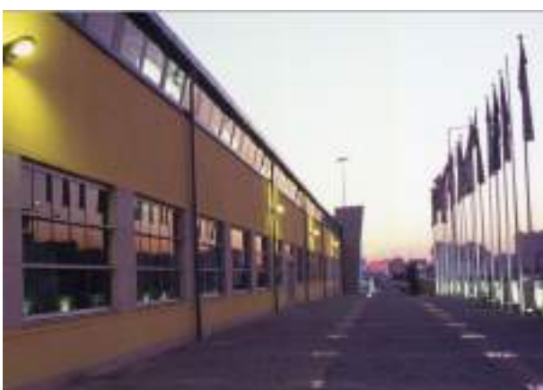
Fig.8 - Fachada lateral integrada.
