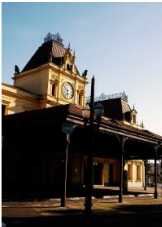
Fig. 4 - Estação de Santos. Em primeiro plano a estrutura metálica recolocada quando da reforma do prédio ocorrida entre 2005 e 2006. Foto: Eduardo Albarello, 2009.
