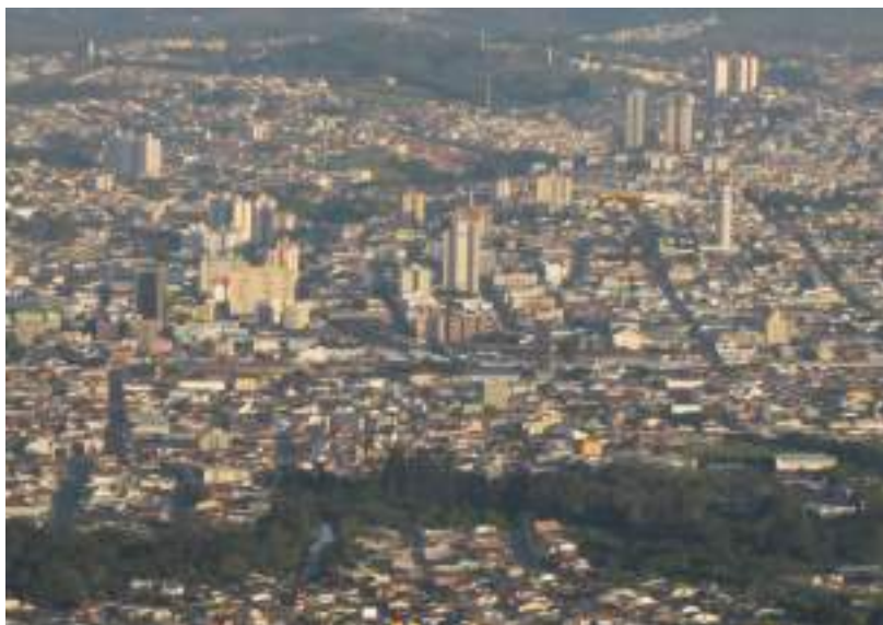
Fig 3 - Perspectiva aérea de Mogi das Cruzes tendo em primeiro plano a situação da área da COSIM , com o conjunto fabril demolido. Foto de autoria desconhecida, 2014.
