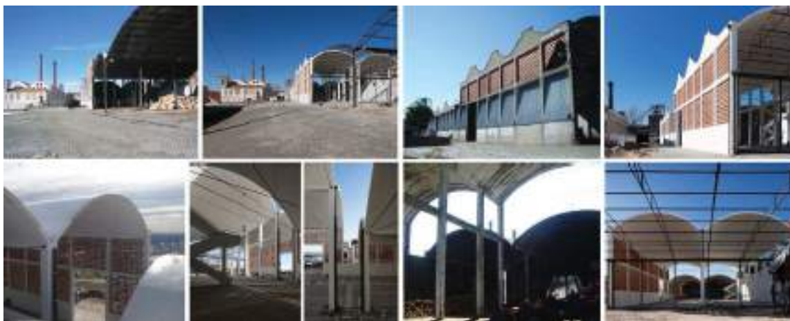
Fig. 9 - Estacionamento de Portalegre - antes e depois.
