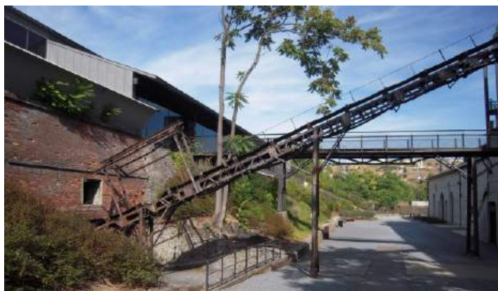
Fig. 2 - Fotografía del espacio de transición entre el Muelle de Carbones y la Central Térmica (9.9.2011).
