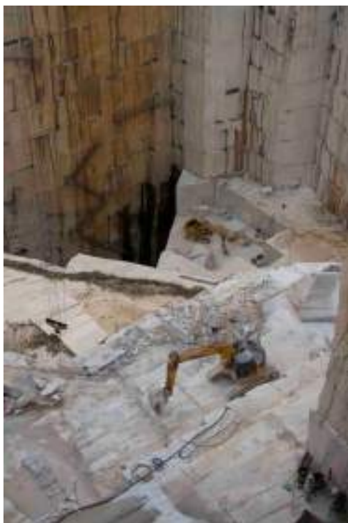
Fig. 8 - Aspectos da exploração das pedreiras.
