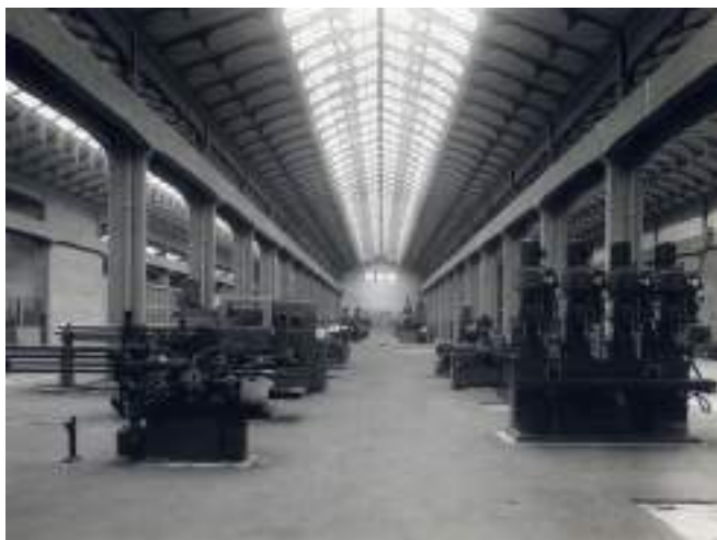
Fig. 4 - Interior de nave de Trefilado en fábrica de La Aldea. Década 1950 (Colección particular).
