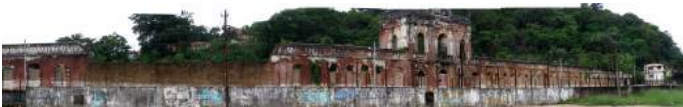
Fig.3 – Vista geral da Fábrica São Braz (foto realizada pelo autor, 20/05/2006).
