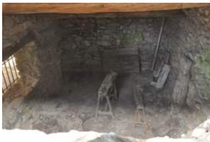
Fig. 7 – “Fábrica Velha” (aspecto interior). Foto: Eduardo Beira.
