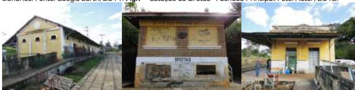
Fig. 8 - Armazém para cargas com ramal. Fig. 9 - Cabine de controle de tráfego e Sanitário. Fig. 10 - Fachada lateral - sala de bagagens com acesso lateral coberto. Fotos: Autor, 2012.
