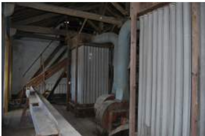
Fig.9 - Vista geral, piso 2, (Foto de autor, 7 de Jun. 2011).
