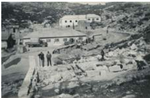
Fig. 12 - Infraestruturas mineiras do Núcleo 4, espaço mineiro Carris. Edifícios de apoio à lavra (serralharia e forja); edifício de afinação/separadora e fase de construção dos edifícios para albergar os geradores (fotografia da década de 1950) (in Barbosa, 2013).
