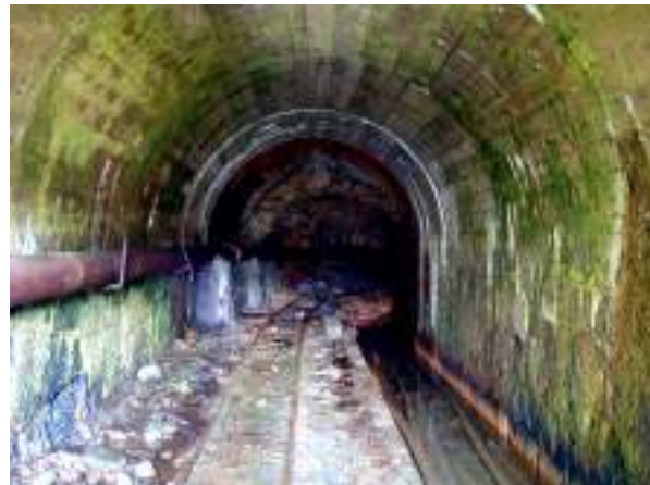
Fig. 8 - Minas da Borralha – Galeria subterrânea (foto do autor, 2000).
