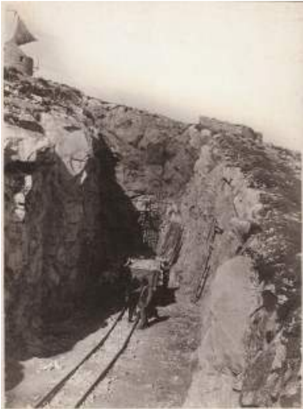
Fig. 3 - Escavação na serra da Pevide para passagem do comboio mineiro. Foto The Match & Tobacco, 1927. AHDGEG/LNEG.
