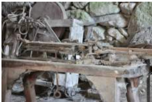
Fig. 6 – Máquinas ainda existentes na “Fábrica Velha”. Foto: Eduardo Beira.
