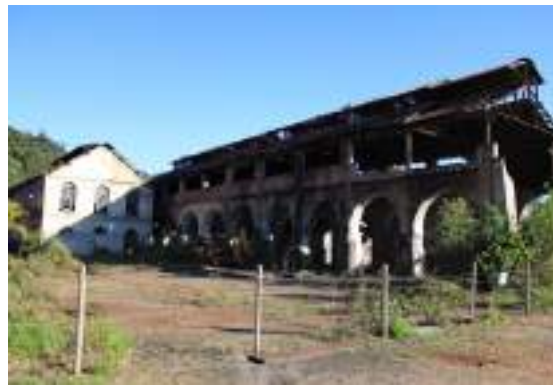
Fig. 17 - Detalhe das aberturas em arco da fachada lateral esquerda da Fundação. Fonte: Acervo Pessoal - 15/06/12.
