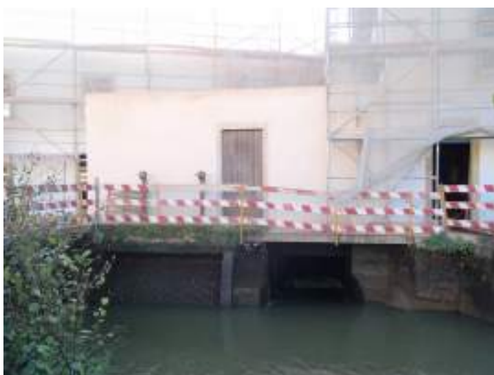
Fig.5 - Comportas, Casa da Turbina. Foto de autor (27 de Dez, 2011).
