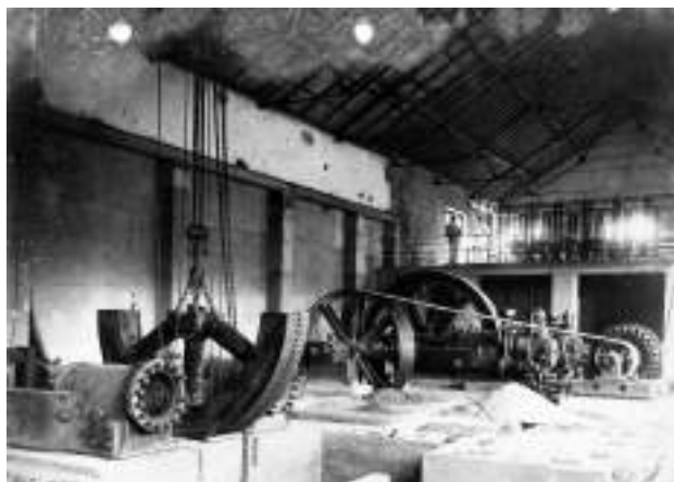
Fig. 2 - Montagem do compressor Bollinckx na Central de 1924.
