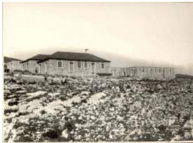
Fig. 2 - Bezerra: O bairro operário em construção. Foto The Match, 1927. AHDGEG/LNEG.
