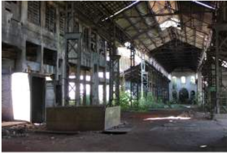
Fig. 11 - Vista da estrutura metálica treliçada do Vão da ponte rolante e da Oficina Mecânica - Antiga Cia Belgo Mineira. Fonte: Acervo Pessoal - 15/06/12.
