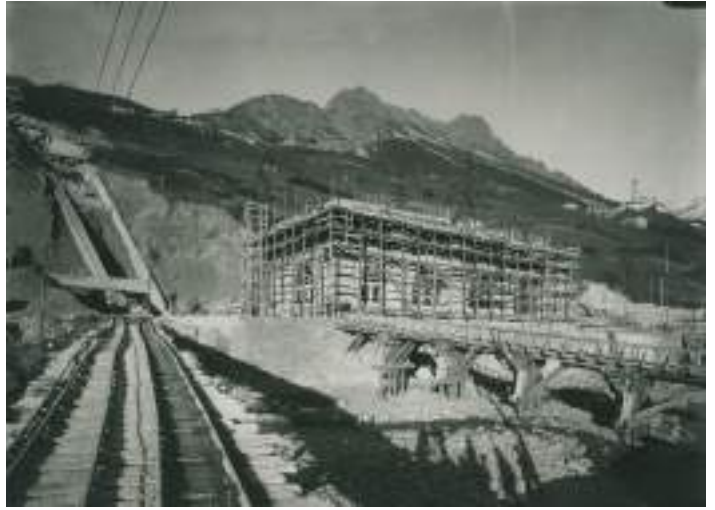
Fig. 2 - The Fraele power plant under construction, circa 1927 [© Archivio Fotografico Fondazione AEM, A2A Group].
