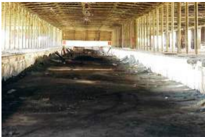
Fig. 6 - Interior do antigo Armazém de Importação. Notar as fileiras de colunas ao centro, próximas à plataforma, onde as composições entravam para serem descarregadas. Apesar da falta de uso e manutenção, a estrutura de sustentação da cobertura encontrava-se totalmente íntegra. Foto: Eduardo Albarello, 2009.
