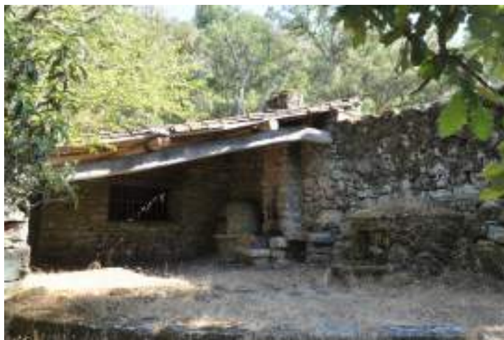
Fig. 4 – “Fábrica Velha” (aspecto exterior). Foto: Eduardo Beira.
