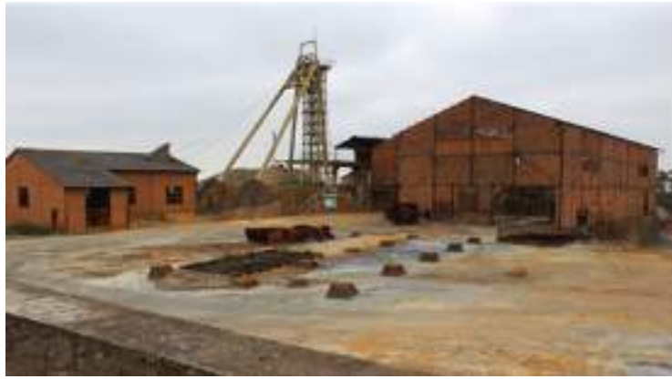
Fig 3 - Edifício da trituração do minério (“Concassage”) e malacate do poço nº 1 (poço de extração da pirite).
