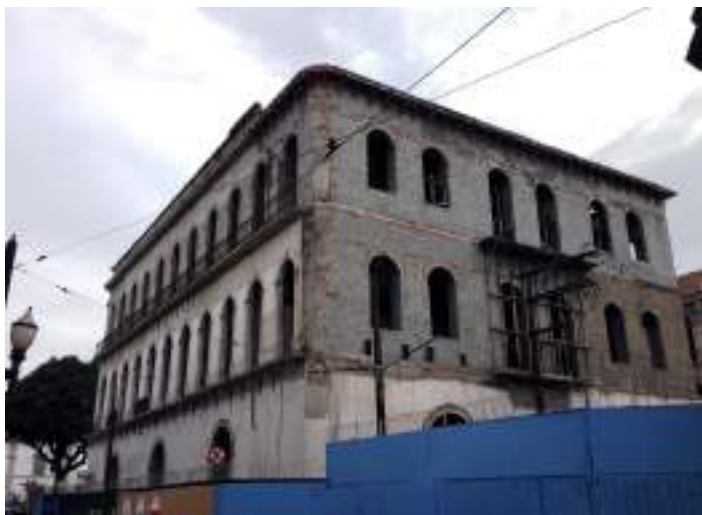
Fig. 3 - Vista de um dos casarões do Valongo em obras. Foto: Antonio Soukef Júnior. Junho de 2013.
