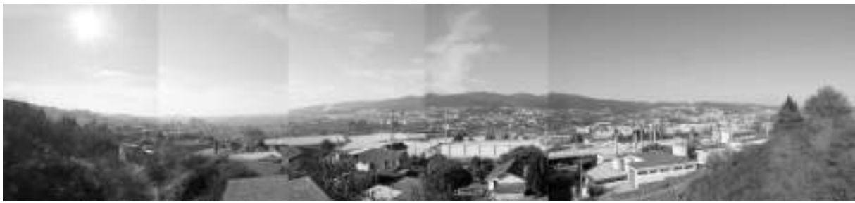
Fig. 6 - Levantamento fotográfico parcial do complexo industrial «Carides». (fonte das imagens: autor)
