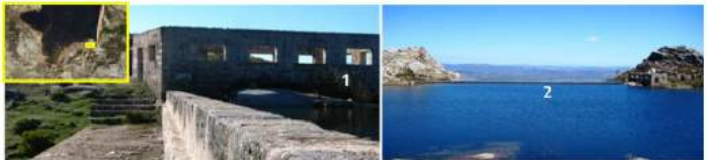
Fig. 8 - Infraestruturas mineiras do Núcleo 2 (fotografia de 2011) (in Gonçalo, 2013). LEGENDA: 1 - Edifício de apoio; 1 - Represa dos Carris (local de armazenamento de água).
