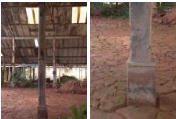
Fig. 9 - Detalhe do pilar em madeira no Galpão da Mecânica - Morro Velho. Fonte: Acervo Pessoal - Março, 2011.
