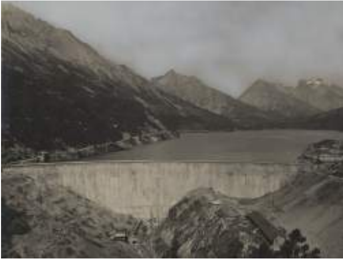
Fig. 1 - The Fraele Dam upon completion, circa 1930 [Archivio Fotografico Fondazione Azienda Elettrica Municipale di Milano, A2A Group].
