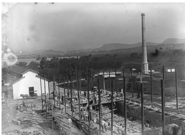
Fig. 2 – Construção dos alicerces da Cavalariça com vista da chaminé dos fornos incineradores. Fonte: DAD/COC.
