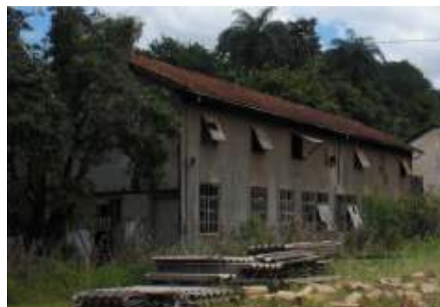
Fig. 33 - Prédio da Modelagem - Mina de Morro Velho, Nova Lima. Fonte: Acervo Pessoal - Março de 2011.
