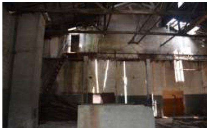
Fig. 3 - Imagem interna de um dos pavilhões da Laneira S.A.
