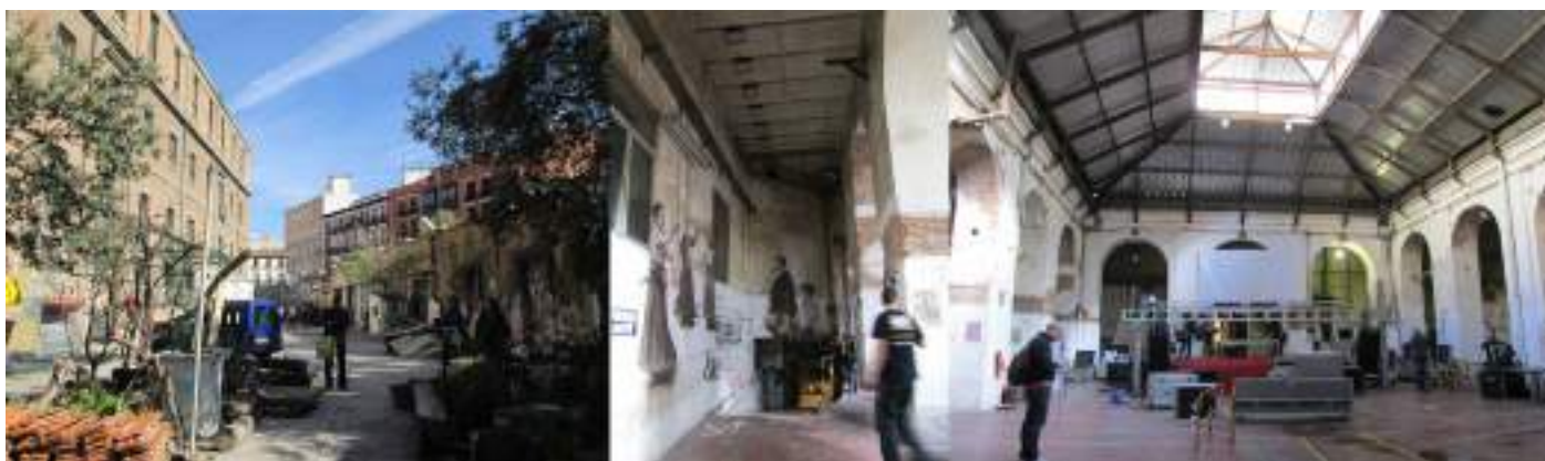
Fig.3 - La mínima intervención de consolidación y mantenimiento gracias a la reutilización de la Fábrica de Tabacos de Madrid como centro social autogestionado permite una lectura del edificio original. La memoria de la antigua tabacalera está muy presente tanto en el respeto por los elementos originales como en las actividades del propio centro como murales o su identidad gráfica. Fuente: Elaboración propia (2013).
