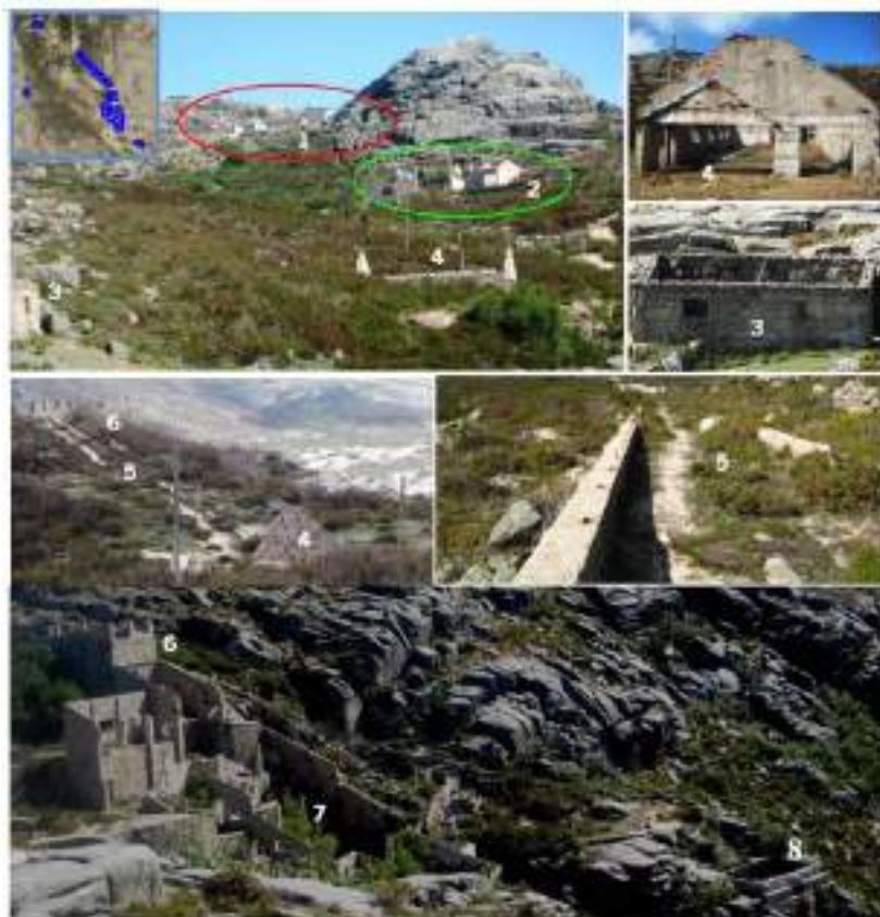
Fig.13 - Infraestruturas mineiras do Núcleo 5 (fotografias de 2011) (adaptado de Gonçalo, 2013).
