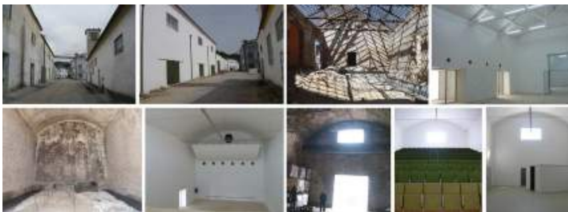
Fig. 10 - ICT-VR e Auditório - antes e depois.
