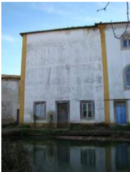
Fig.4 - Casa da Turbina, fachada norte, DOM-CMT (3 de Fev. 2011).
