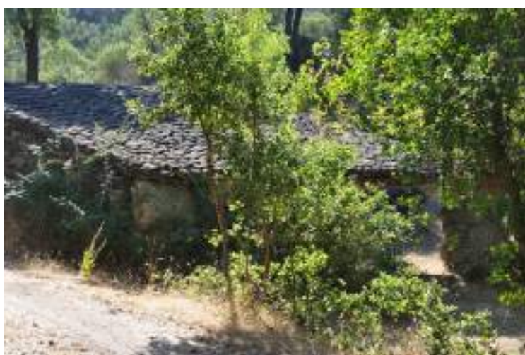
Fig. 3 – “Fábrica Velha” [aspecto exterior]. Foto: Eduardo Beira.
