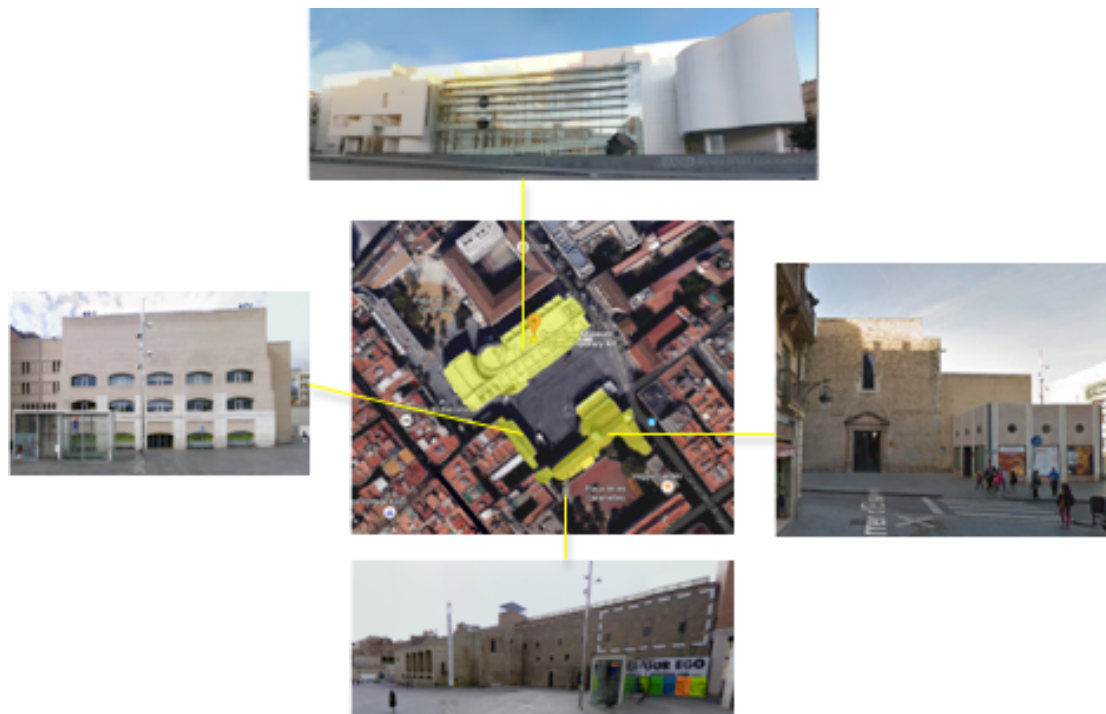
Figura 1 - Instalações do MACBA na Plaça dels Àngels. Fonte: internet
