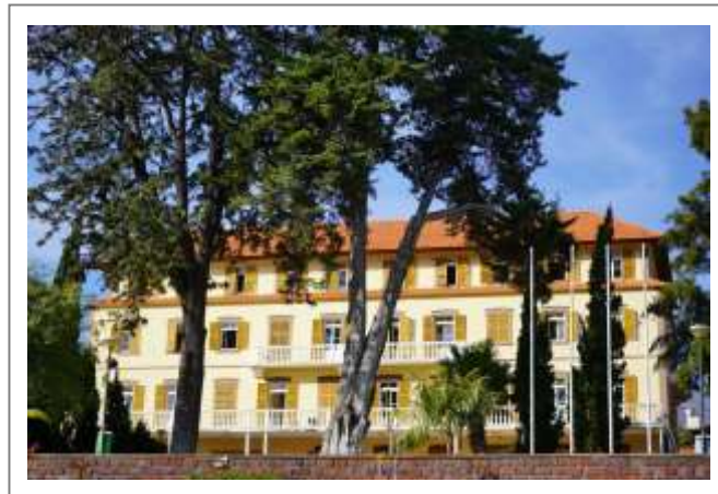
Fotografia 5 - Conservatório - Escola Profissional das Artes da Madeira
