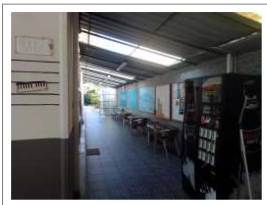
Fotografia 3 – Corredor inferior de acesso às salas
