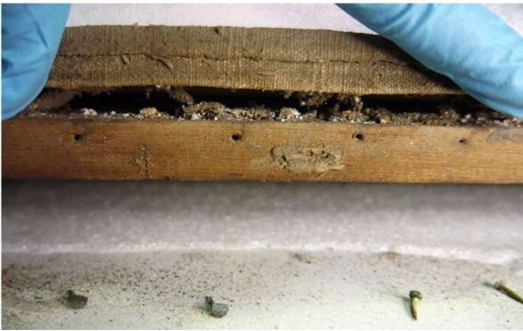
Fig. A108 – Separação da tela da grade após remoção das tachas metálicas
