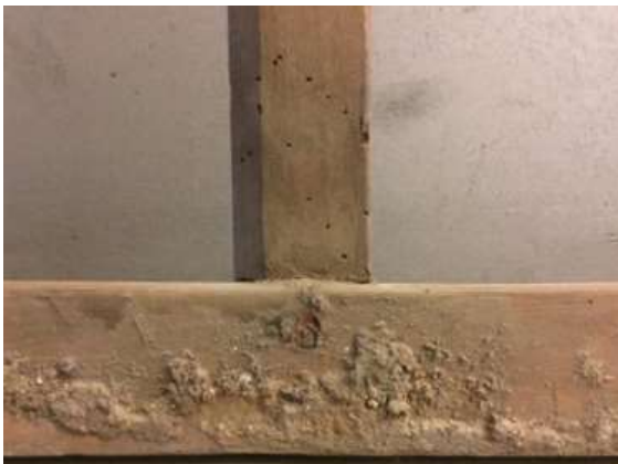
Fig. A16 – Travessa vertical fixada à travessa inferior da grade
