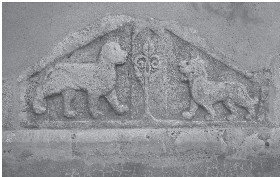
Figura 10: Igreja de São João Baptista (c. Tomar). Tímpano românico reaproveitado na caixa murária da fachada principal
