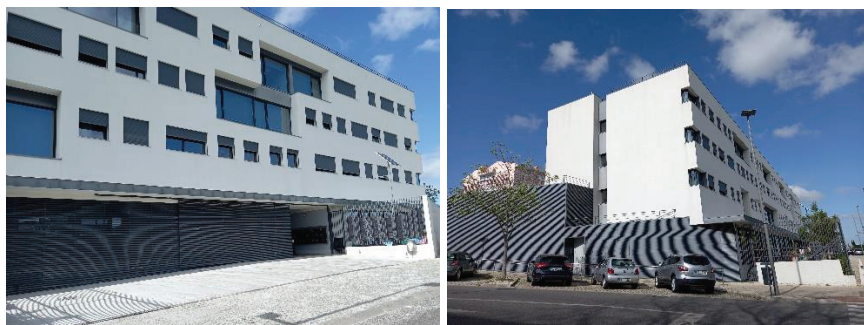
Fig. 4, 5 e 6 – Fachada do prédio
