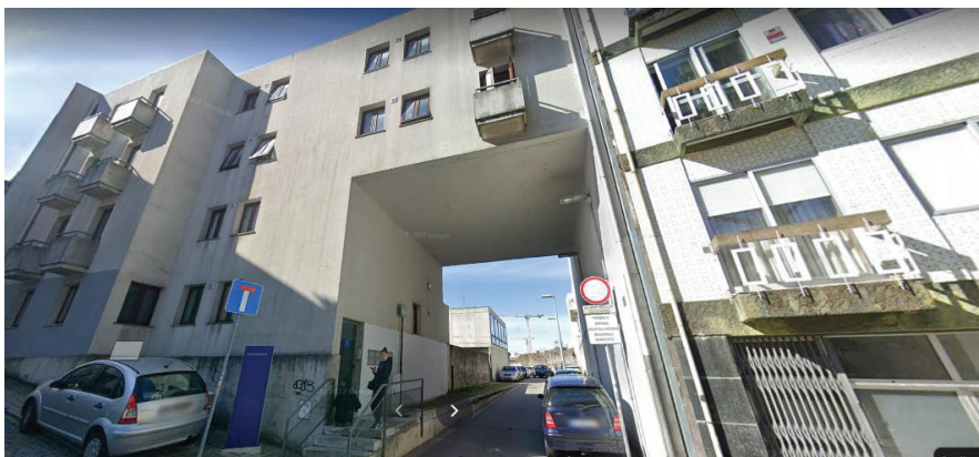
Fig. 29 – Fachada do prédio (Bairro das Fontainhas)
