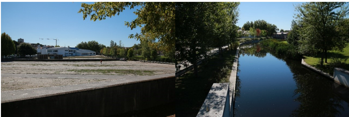
Fig. 75 e 76- Largo da feira e ao fundo a Escola da Ribeira, 2016. | Rio Pavia, 2016 Fonte: Autor, 2016
