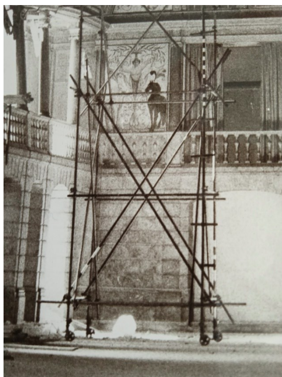
Fig. 70 – Parede Norte com os andaimes c. 1975. AR-BMNC, accedido a 16.06.21.
