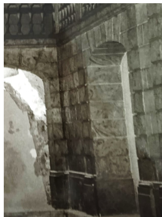
Fig. 71 – Parede Norte do lado Poente c. 1975. AR-BMNC, accedido a 16.06.21.
