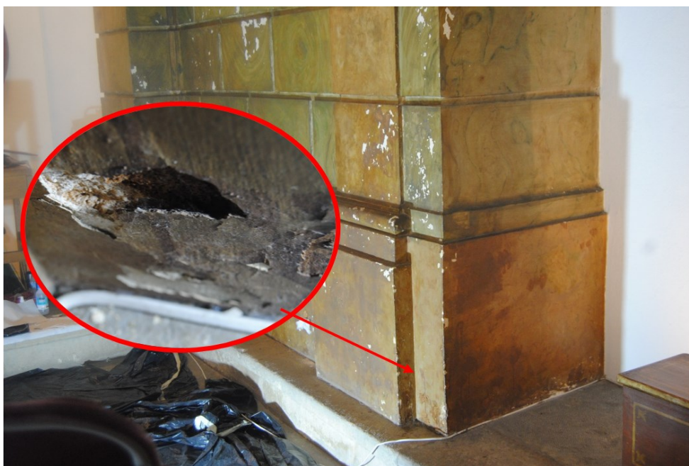
Fig. 29 – Aspeto geral da zona inferior adocada ao nicho, antes e após preenchimento de massas (24.06.2021) Margarida Nunes©
