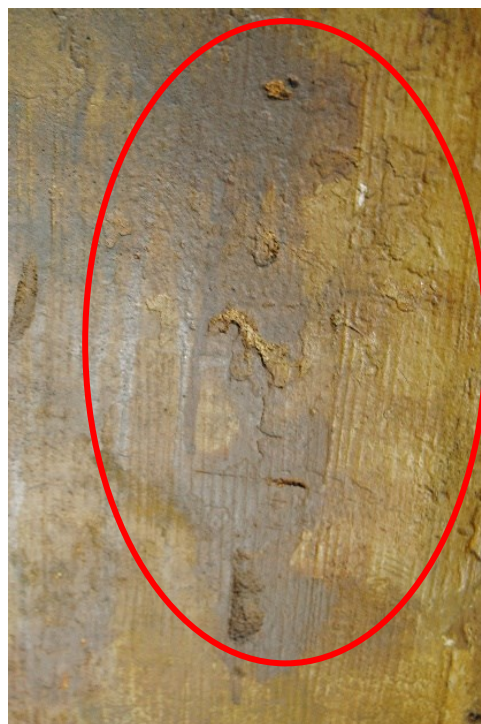
Fig. 61 – Janelas de limpeza. (25.05.21) Margarida Nunes©.
