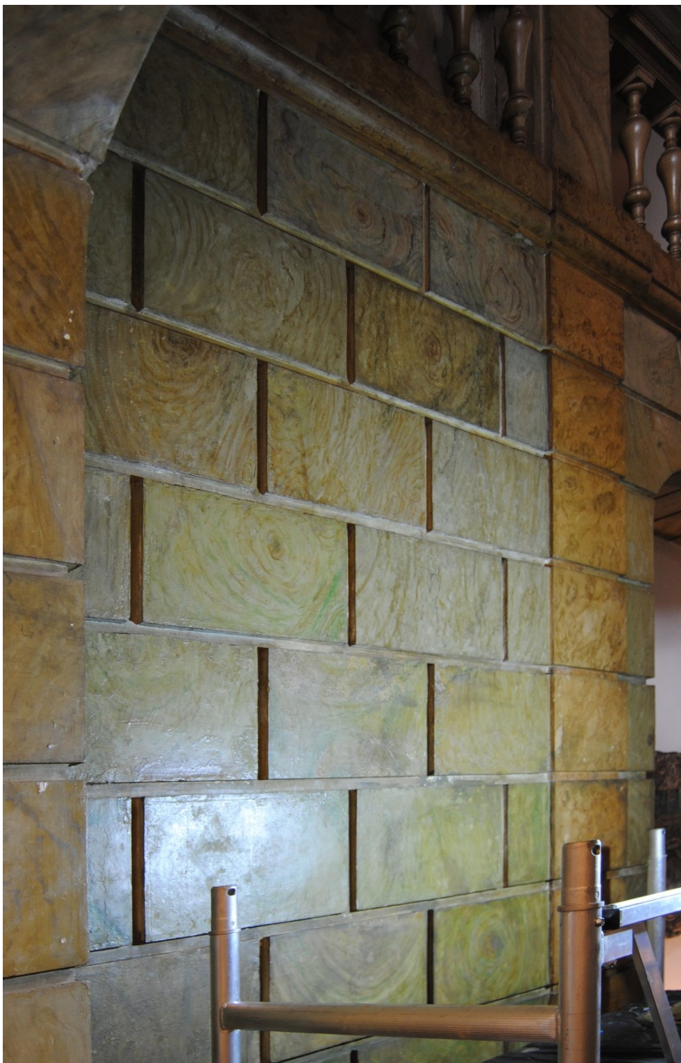
Fig. 135 – Aspeto geral da obra na última fase de intervenção. (03.03.2022) Margarida Nunes©
