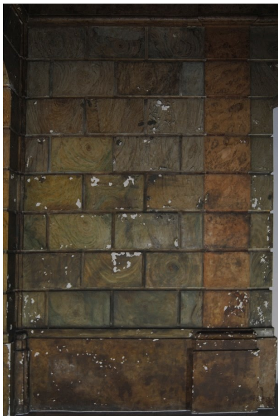
Fig. 136 – Aspecto geral da obra antes do restauro (01.06.2022) Margarida Nunes©
