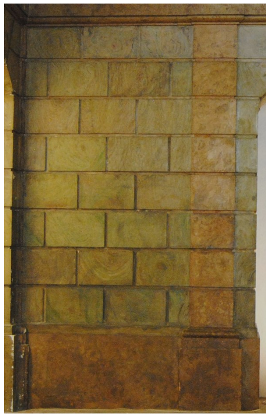
Fig. 137 – Aspecto geral do painel após intervenção (03.04.2022) Margarida Nunes©
