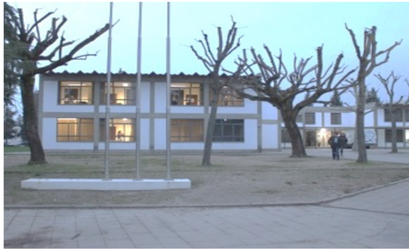
Figura 1 - Instalações da AMSFV
