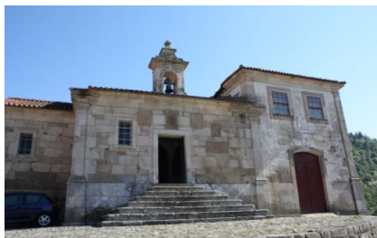
Fachada principal da igreja, virada a norte e esquina que confina com o solar dos Viscondes de Balsemão (foto do autor).
