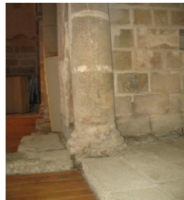
Colunas que fecham a iconostase, vendo-se o corte feito nas bases para assentar uma cancela (fotos do autor).
