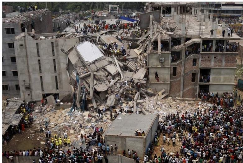
Fig.4 Colapso do edifício Rana Plaza no Bangladesh. Fonte: Jornal Público Online, 12 Maio 2013
