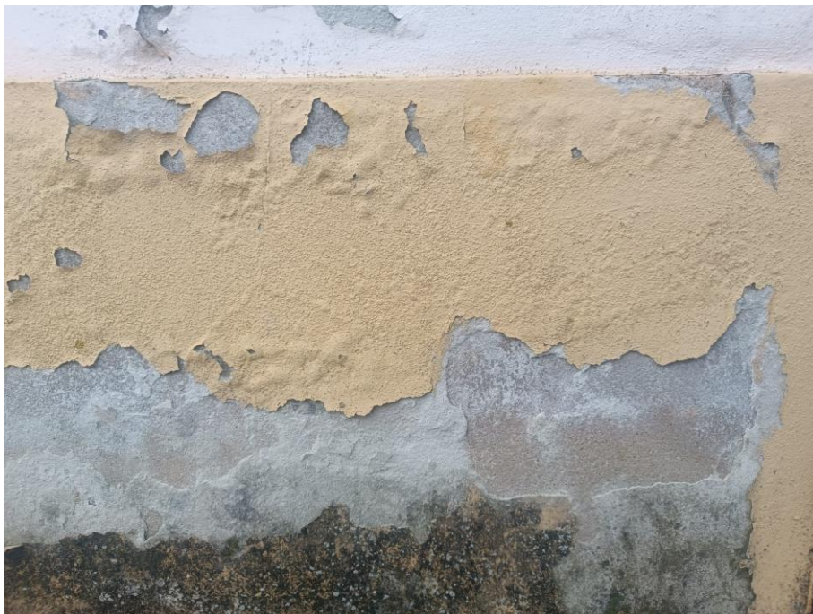
Fig. A.12. – Destacamento Fachada. Fonte – Beatriz Lemos©2025
