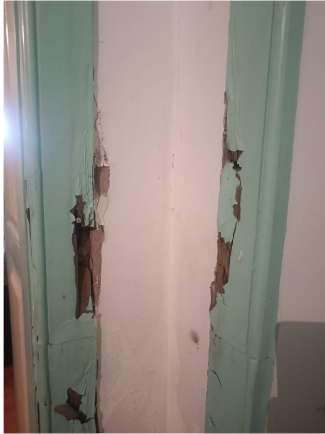
Fig. A.11. – Destacamento Madeira Corredor. Fonte – Beatriz Lemos©2025
