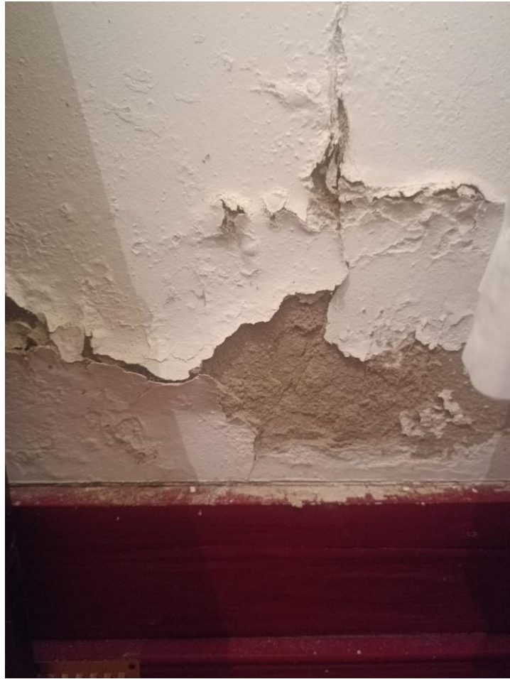
Fig. A.13. – Destacamento Quarto Lateral Esquerdo. Fonte – Beatriz Lemos©2025
