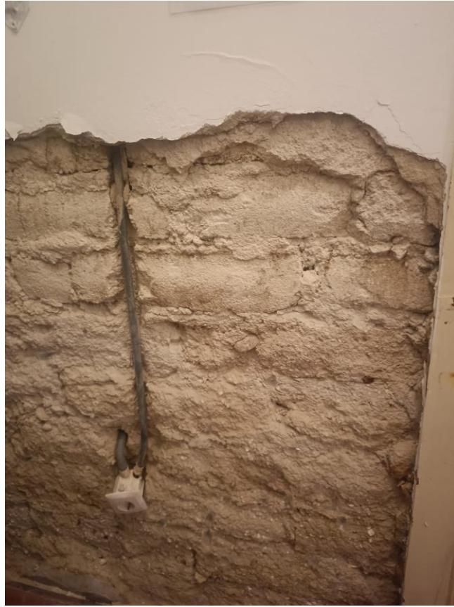
Fig. A.7. – Destacamento de Reboco Corredor. Fonte – Beatriz Lemos©2025
