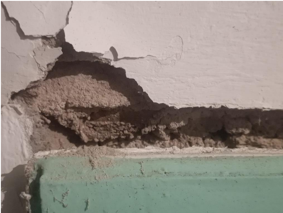
Fig. A.6. – Destacamento Sala de Jantar. Fonte – Beatriz Lemos©2025
