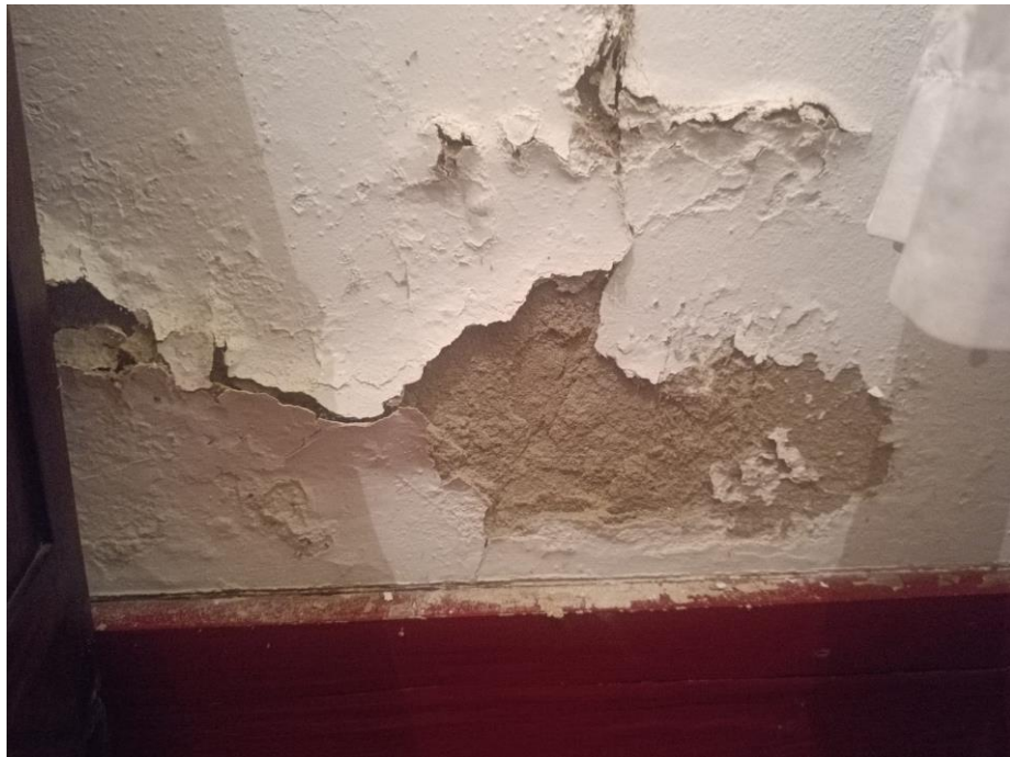
Fig. A.8. – Destacamento Sala de Estar. Fonte – Beatriz Lemos©2025
