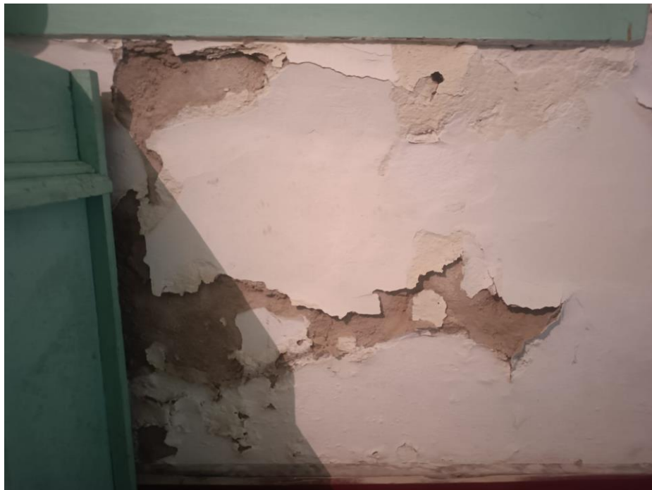
Fig. A.10. – Destacamento Sala de Jantar. Fonte – Beatriz Lemos©2025
