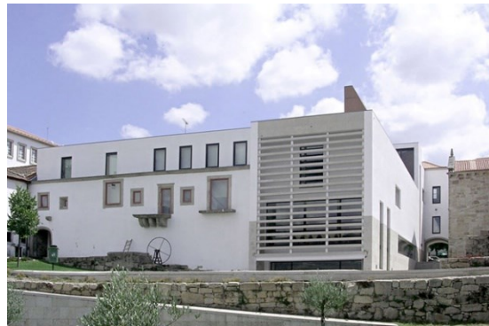
Figura 1: Conservatório Regional de Música de Vila Real.
