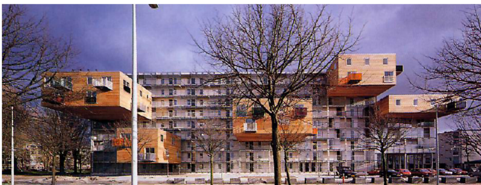
Figura 139 - Fotos dos apartamentos WoZoCo's
