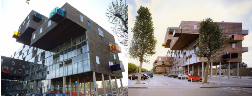
Figura 135 e Figura 136 – Fotos dos apartamentos WoZoCo's
