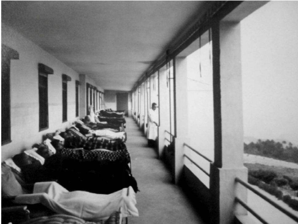
Figura 38 - Fotografia das galerias após a primeira fase de expansão do Sanatório Dr. Jerónimo Lacerda / Grande Sanatório do Caramulo
