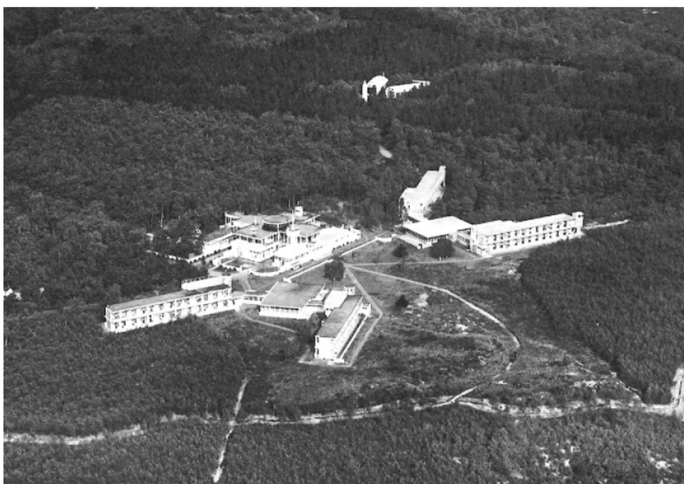
Figura 39 – Foto dos três edifícios do Sanatório Zonnestraal
