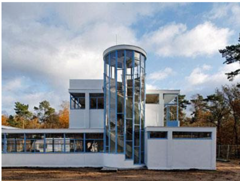
Figura 55 – Foto do Restauro do Sanatório Zonnestraal
