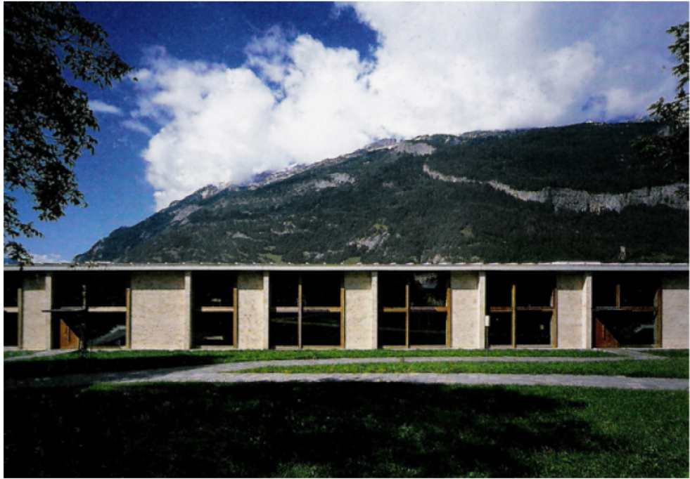
Figura 82 – Foto do Alçado Este da Residential Home for the Elderly
