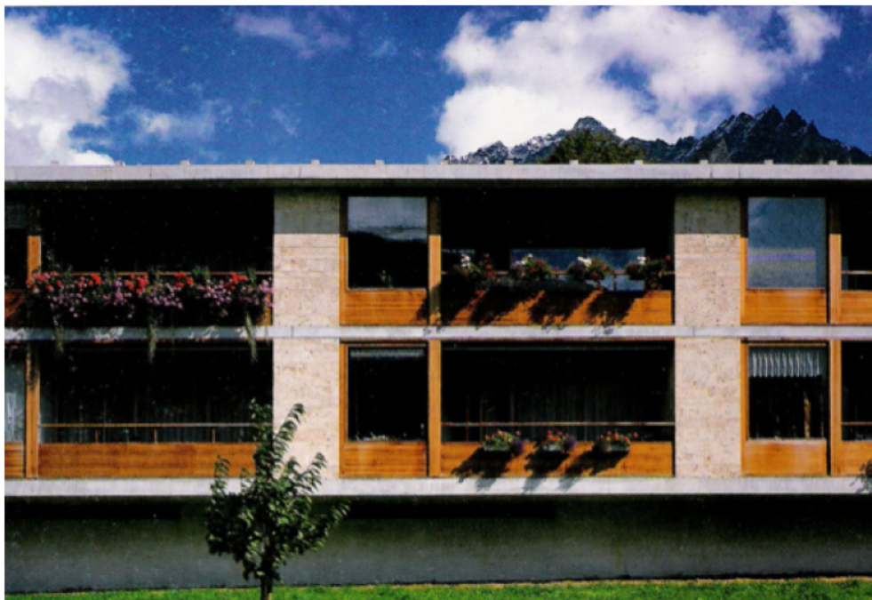
Figura 83 – Foto do Alçado Este da Residential Home for the Elderly
