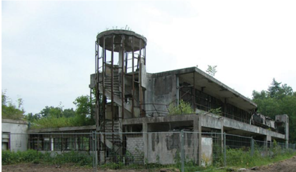
Figura 119 – Ruínas do Sanatório Zonnestraal
