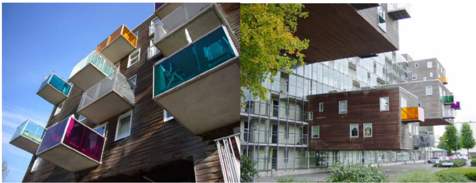
Figura 137 e Figura 138 - Fotos dos apartamentos WoZoCo's
