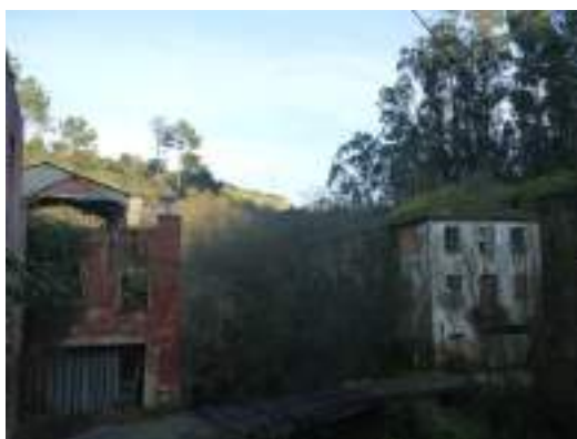
Fig. 4 - Duas unidades fabris, perto do moinho da Vinha, construídas sobre antigos moinhos.
