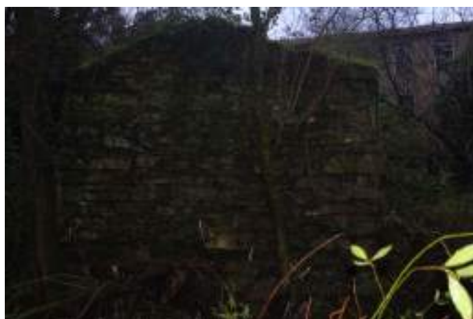
Fig. 3 - Ruína do moinho da Vinha.
