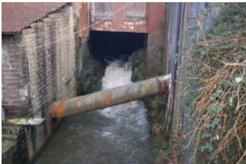
Fig. 9 - Saída do canal que conduz a água para as turbinas da fábrica.
