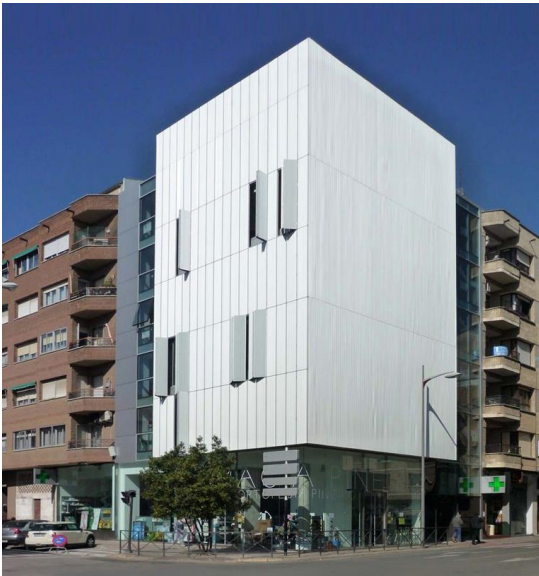
Fig. 67 – Arq. Capilla, Edificio Piñero, Espanha.
