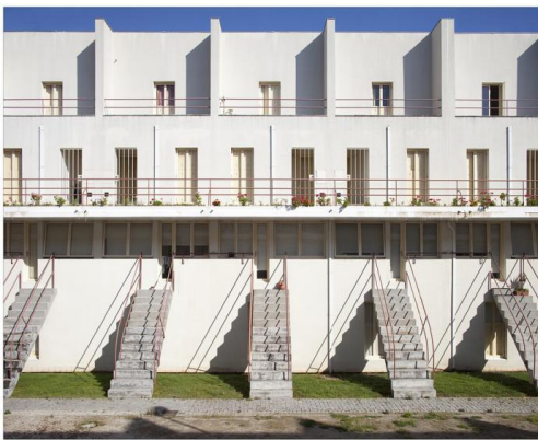
Fig. 11 - SAAL - Álvaro Siza (habitação de baixa altura).
