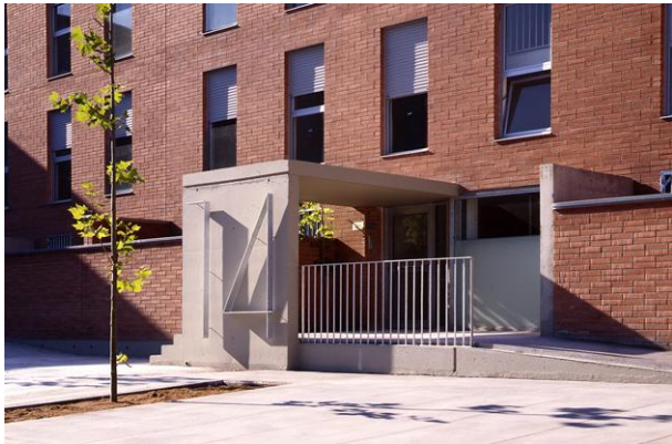
Fig. 65 - Pormenor da entrada principal.
