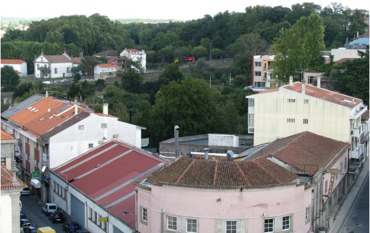
Fig. 31 – Área de intervenção.
