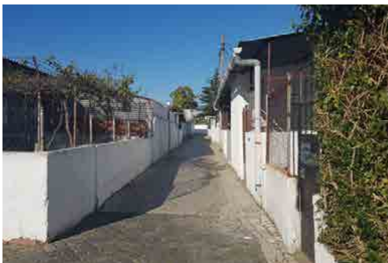
Figura 20 - Casas térreas de alvenaria no bairro da Quinta da Penteeira com logradouros vedados e anexos (atual bairro Padre Cruz). Fonte: própria.
