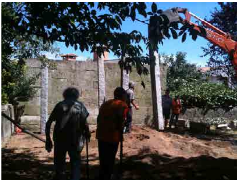
Figura 4 - Trabalhos de construção do Jardim-Escultura (1997-2014): colocação dos esteios. 5 de agosto de 2013. Cortesia Junta de Freguesia do Coronado.
