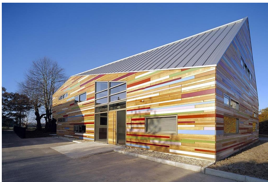
Fig. 35: Day Care Centre de Kleine Kikker – Drost + van Veen Fonte: Robert Hart (2009)
