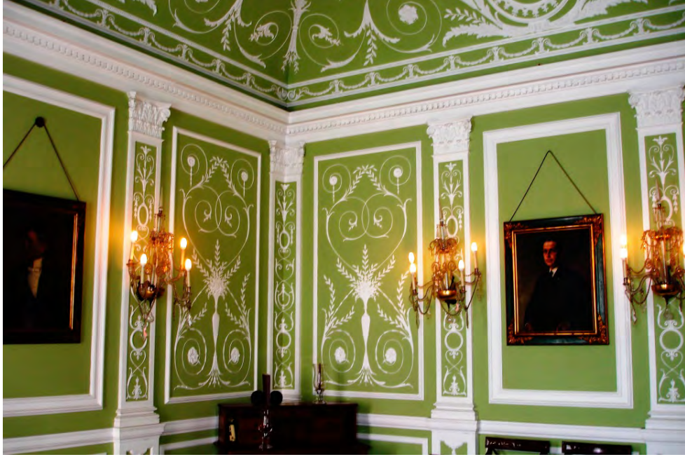
Fig. 5 – O trabalho estucado que recobre os alçados e sanca da sala de visitas (foto da autora).
