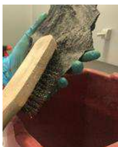
Figura 111 - Limpeza mecânica, para a remoção da argamassa tradicional.
