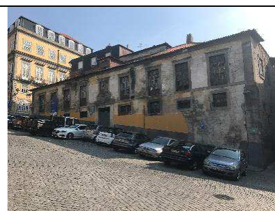
Figura 20 – Vista panorâmica do edifício ©.
