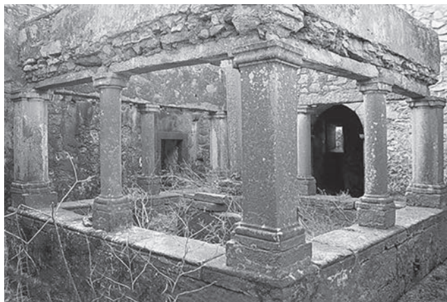
Foto 1 Claustro do convento da Ínsua, edificado em linguagem clássica, com pilares nos ângulos e colunas a meio de cada lado, suportando arquitrave e assentando em muro baixo. Construído em granito.
