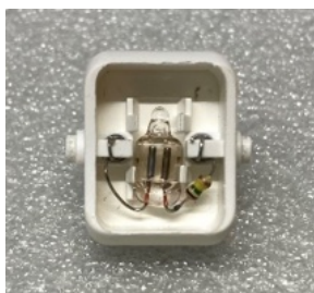
Fig. 95. Desmontagem parcial do interruptor luminoso basculante vermelho de substituição. Fonte: ©Francisca Lafuente.
