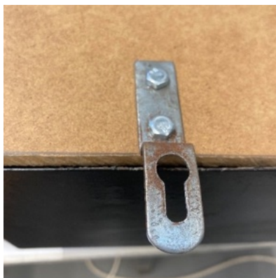
Fig. 34. Ferragem fixa à placa de MDF do elemento 6 por meio de parafusos, anilhas e porcas. Fonte: ©Francisca Lafuente.
