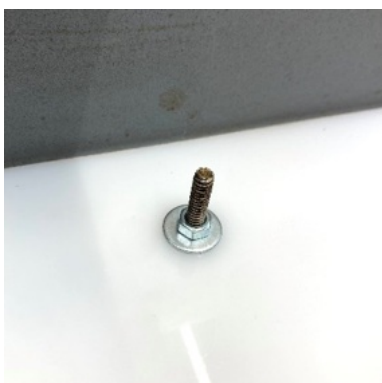
Fig. 87. Substituição dos elementos metálicos de fixação (anilhas e porcas) originais, que se apresentavam bastante oxidados, por elementos novos, idênticos aos anteriores. Fonte: ©Francisca Lafuente.
