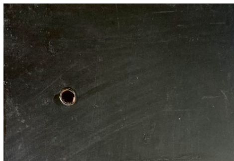
Fig. 41. Perfuração com configuração circular realizada na face inferior da estrutura metálica. Fonte: ©Francisca Lafuente.
