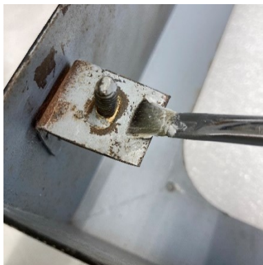
Fig. 109. Aplicação, com recurso a um pincel de cerdas macias, de uma camada da cera microcristalina translúcida RENAISSANCE® Micro-crystalline Wax Polish sobre a superfície do interior da estrutura metálica. Fonte: ©Francisca Lafuente.
