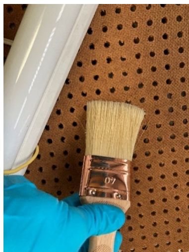
Fig. 76. Limpeza mecânica, com recurso a uma trincha de cerdas macias, do interior dos elementos. Fonte: ©Francisca Lafuente.
