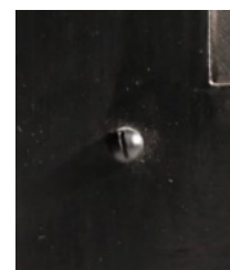
Fig. 22. Registo de pormenor do parafuso de máquina, de cabeça redonda com revestimento a emulsão acrílica preta. Fonte: ©Francisca Lafuente.
