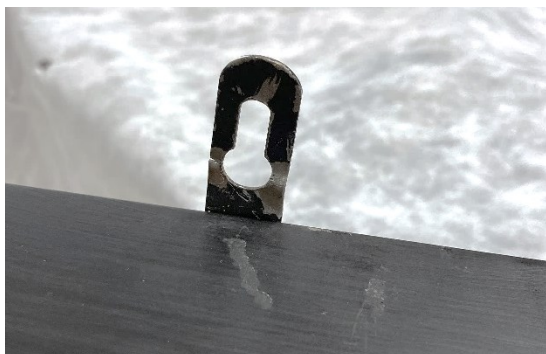
Fig. 52. Exemplo de lacunas e abrasões da camada cromática que reveste uma das ferragem de suspensão do elemento 1 e de uma reintegração cromática detetada na face superior exterior da estrutura metálica do mesmo elemento. Fonte: ©Francisca Lafuente.
