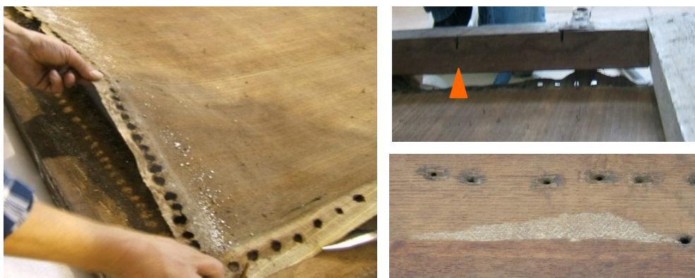
Fig. 3.33 – À esquerda, pormenor da tela com os orifícios dos elementos metálicos. No topo direito, orientação dos pregos que prendiam a tela à grade. Em baixo, pormenor da distribuição dos pregos na grade (cortesia da empresa Porto Restauro Lda.).
