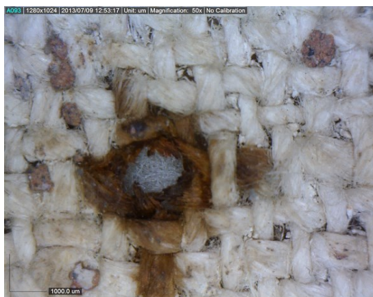
Fig. 5.3 – Na pintura tardo-medieval Nossa Senhora do Rosário (Apêndice 3, ficha 1) é visível a degradação do suporte celulósico por oxidação dos elementos metálicos.
