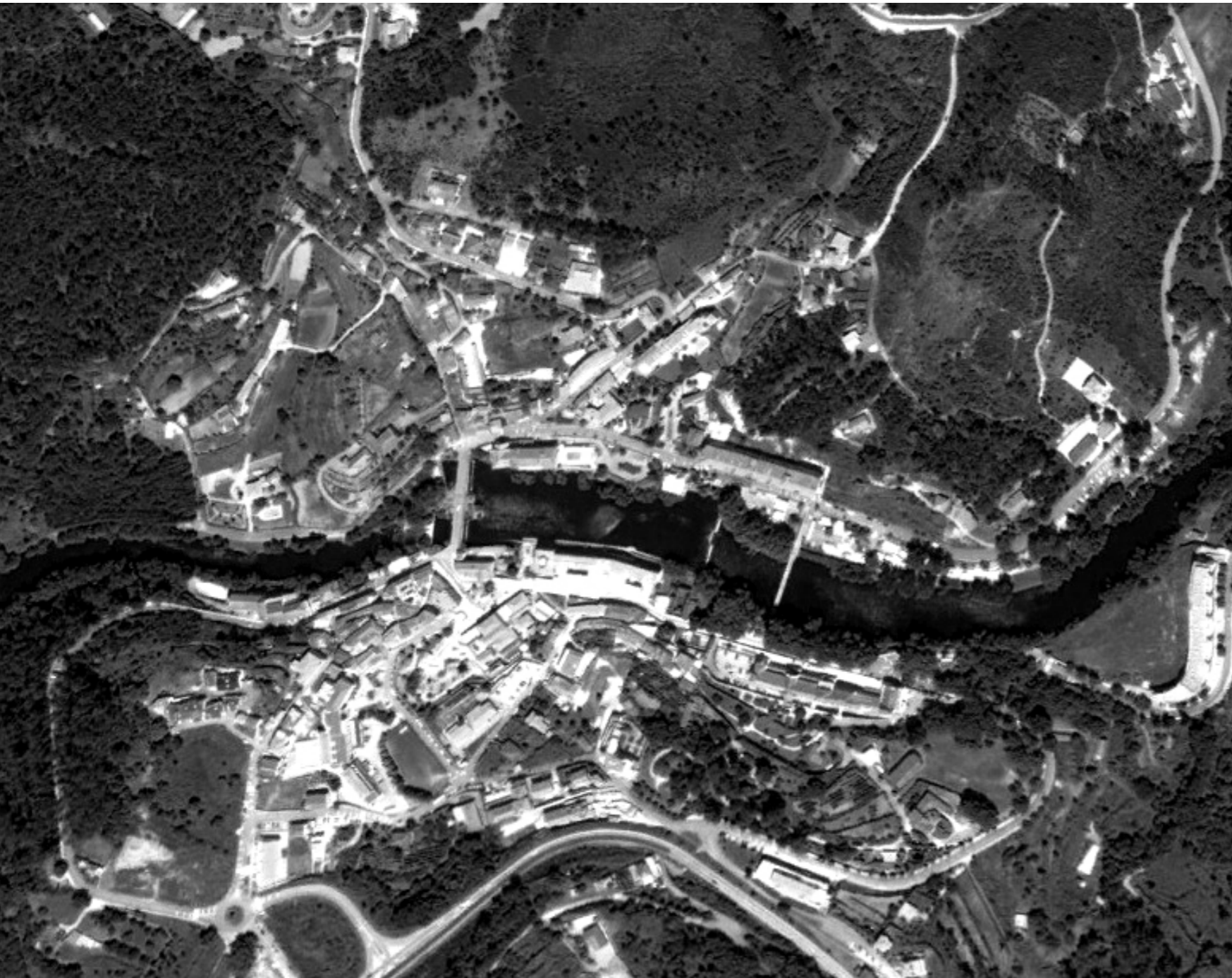
F.14 — Vista aérea das Termas de São Pedro do Sul FONTE Google Earth
