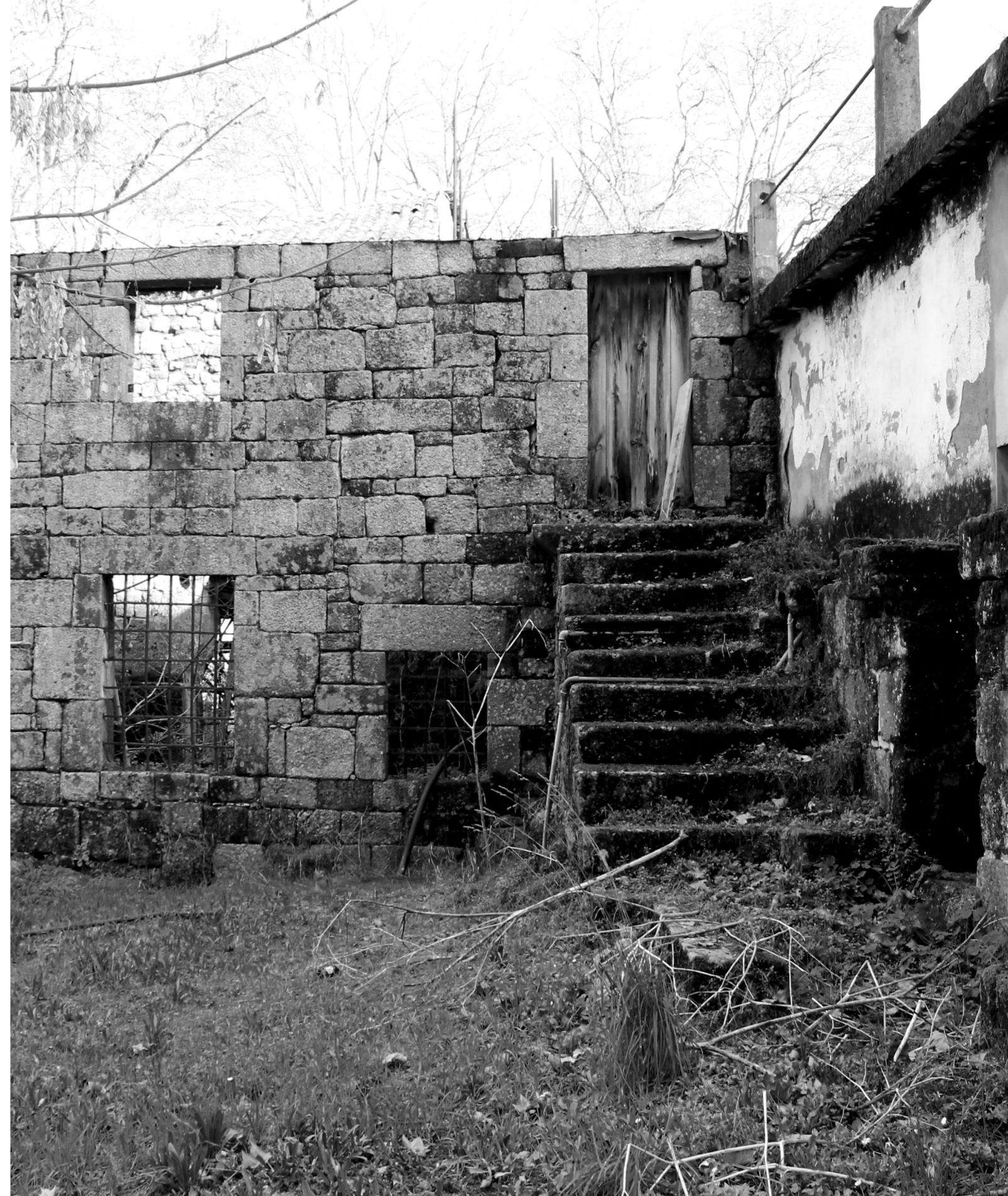
F.10 — Escadas exteriores das Termas Romanas de São Pedro do Sul
