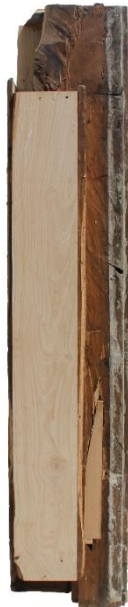
Figura 44 - Vista do reverso da pilastra do lado direito
