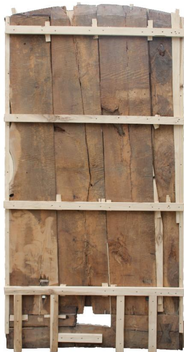
Figura 42 – Vista geral do reverso do camarim.
