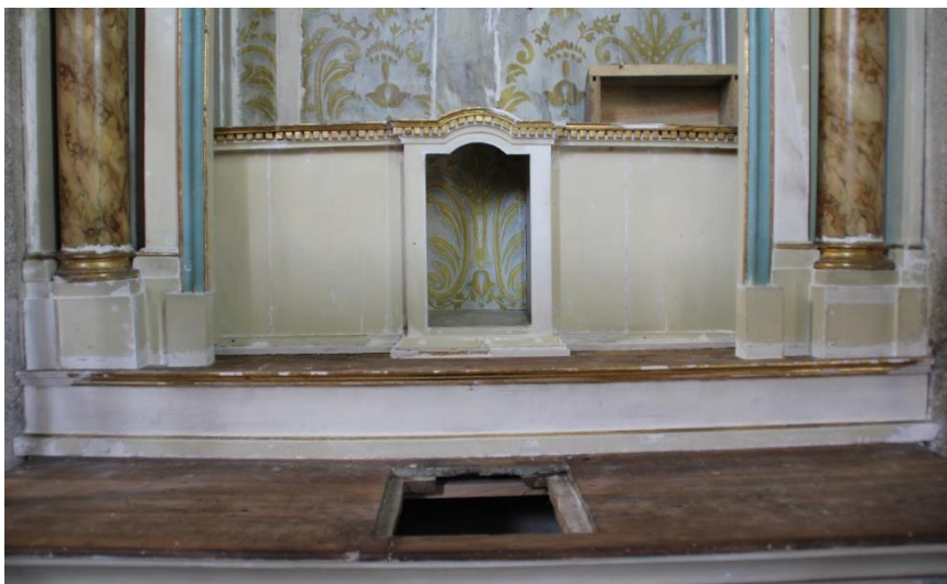
Figura 38 – Vista parcial durante a aplicação de massas de preenchimento
