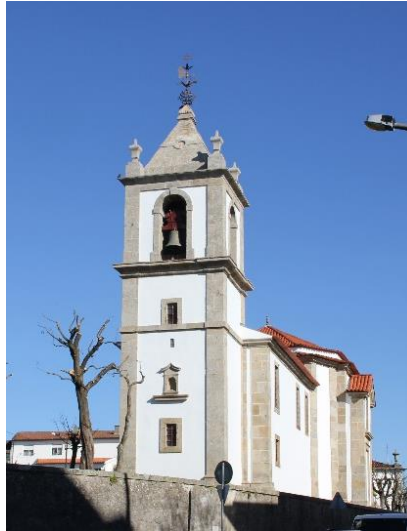
Figura 2 - Fotografia da Torre Sineira da Capela de São Sebastião das Carvalheiras
