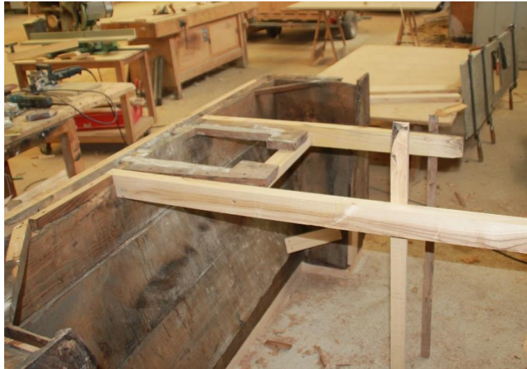
Figura 19 - Pormenor do tratamento do suporte realizado na mesa do retábulo
