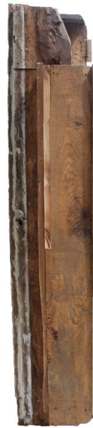
Figura 43 - Vista do reverso da pilastra do lado esquerdo
