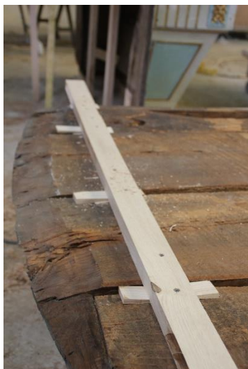
Figura 23 - Pormenor da colocação de uma travessa de reforço no fundo do camarim
