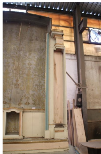
Figura 27 - Pormenor da montagem da pilastra do lado direito em oficina
