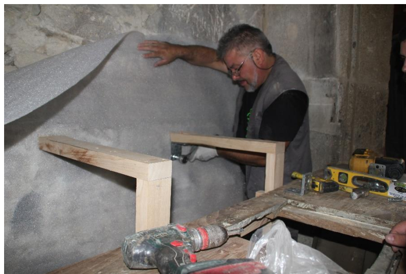
Figura 32 - Pormenor da fixação dos barrotes à parede fundeira. Evidencia-se ainda um fragmento da manta de espuma de polietileno
