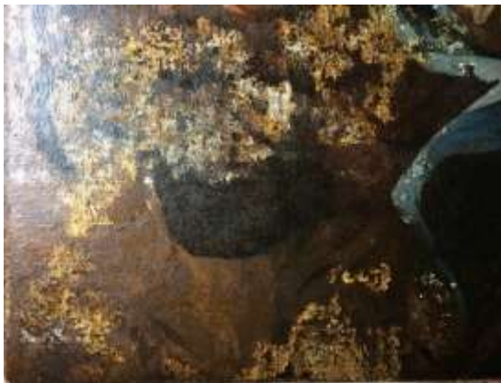
Fig. 74 - Pormenor da área inferior esquerda durante a intervenção.
