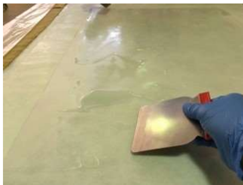
Fig. 67 - Aplicação da resina HB Eposurf® na área central da fibra de vidro.
