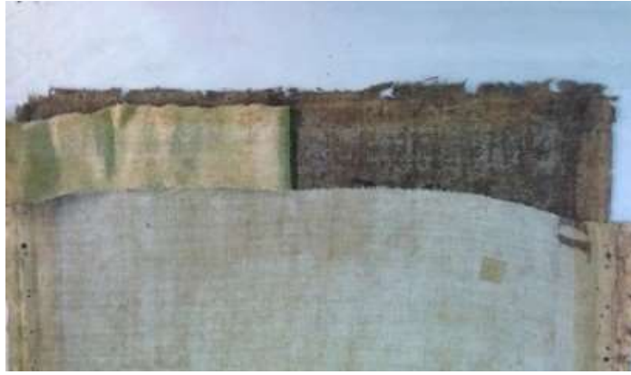
Fig. 55 - Fotografia do início do processo de remoção da tela de reforço.
