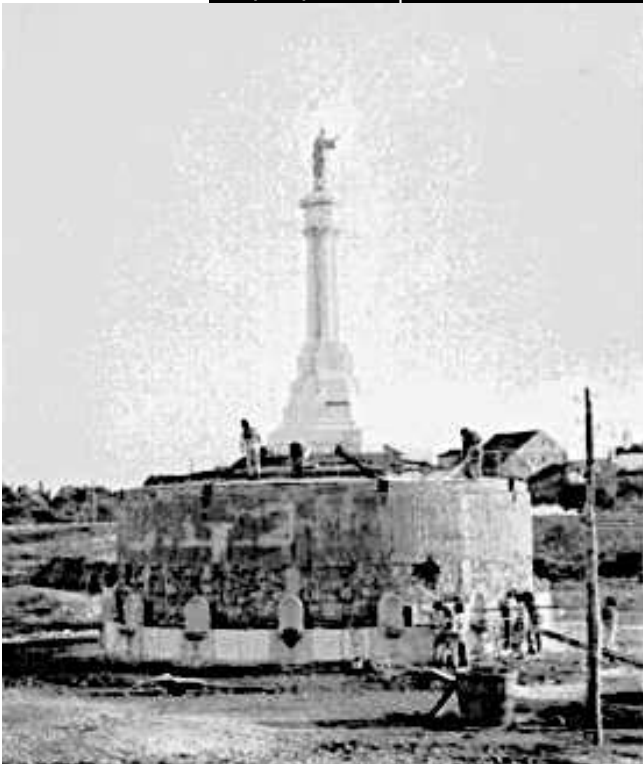
FIGURA 7 | Obras de construção do monumento https://historiasnovaseternas.blogspot.com/2019/10/a-fonte-de-agua-milagrosa-de-fatima.html .
