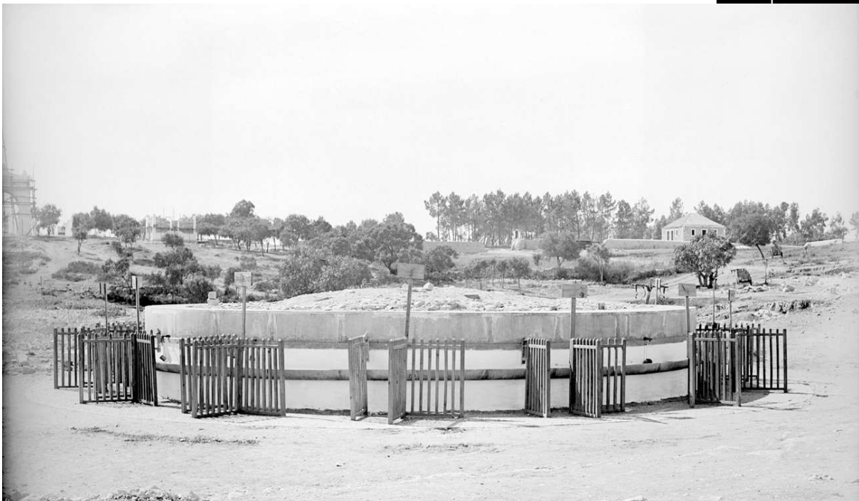
FIGURA 34 | Construção do muro circular e torneiras em torno do poço primitivo (>1926).
