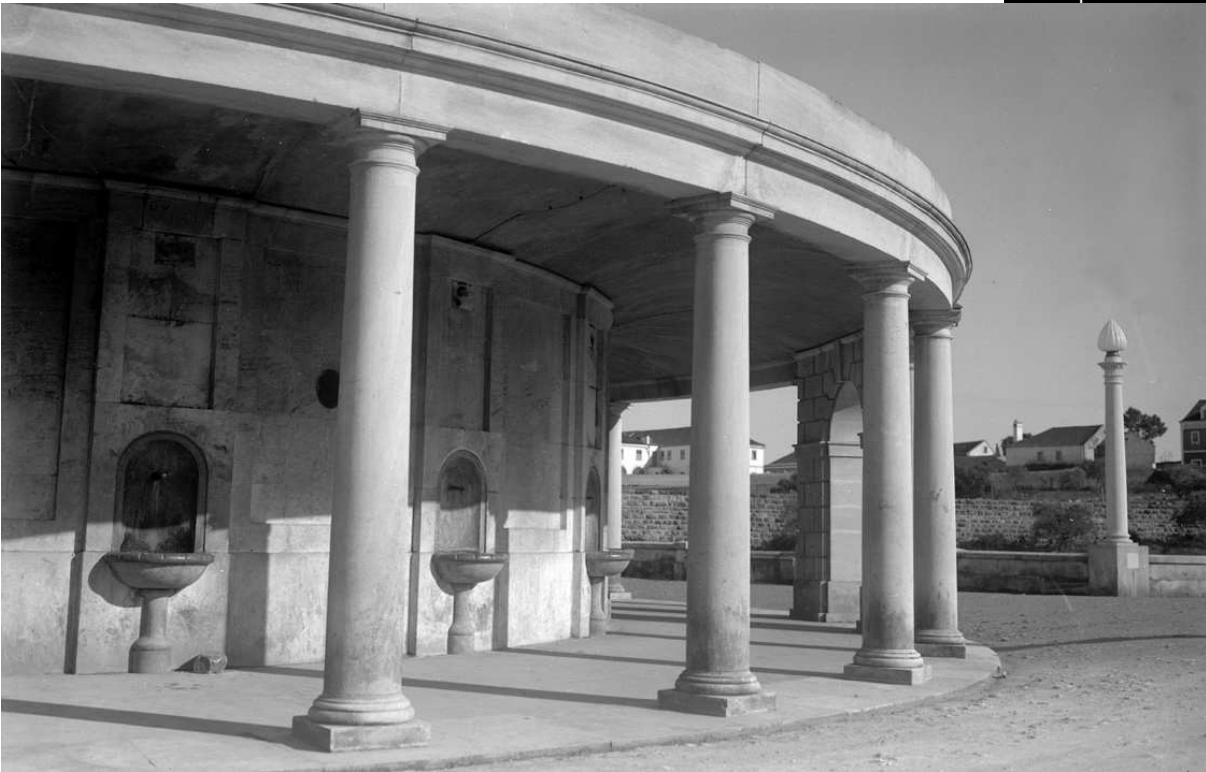
FIGURA 32 | Vista da galeria e das fontes do exterior.
