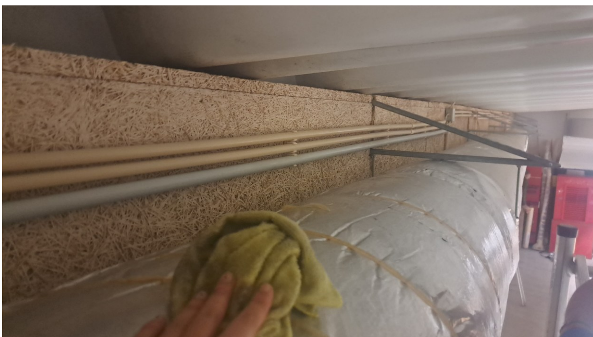
Fig. Apêndice 20 – Processo de limpeza das condutas da reserva. Fotografia da autora.
