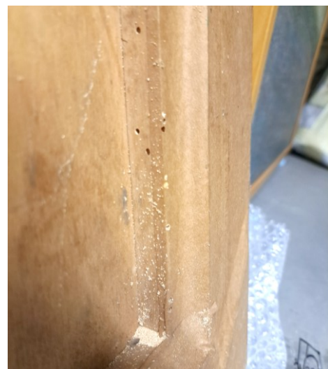
Fig. 16 - Obra com sinais de infestação ativa. Fotografia da autora.
