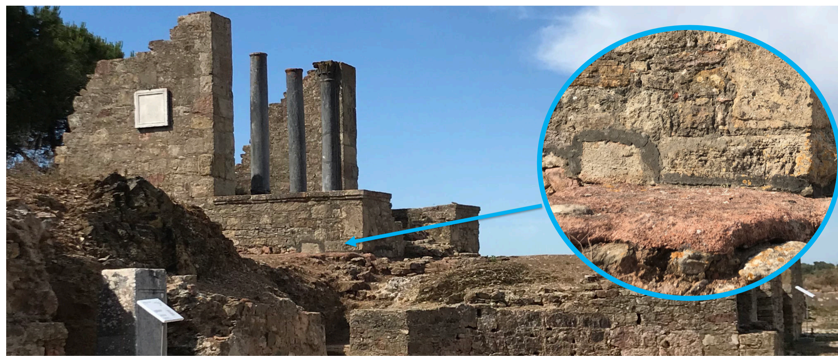
Fig. 1 Templo de las Ruinas Romanas de Miróbriga (vista detallada de las líneas separadoras" entre los materiales añadidos y el original, de las restauraciones de D. Fernando d' Almeida). Mariana Durana © 2022.
