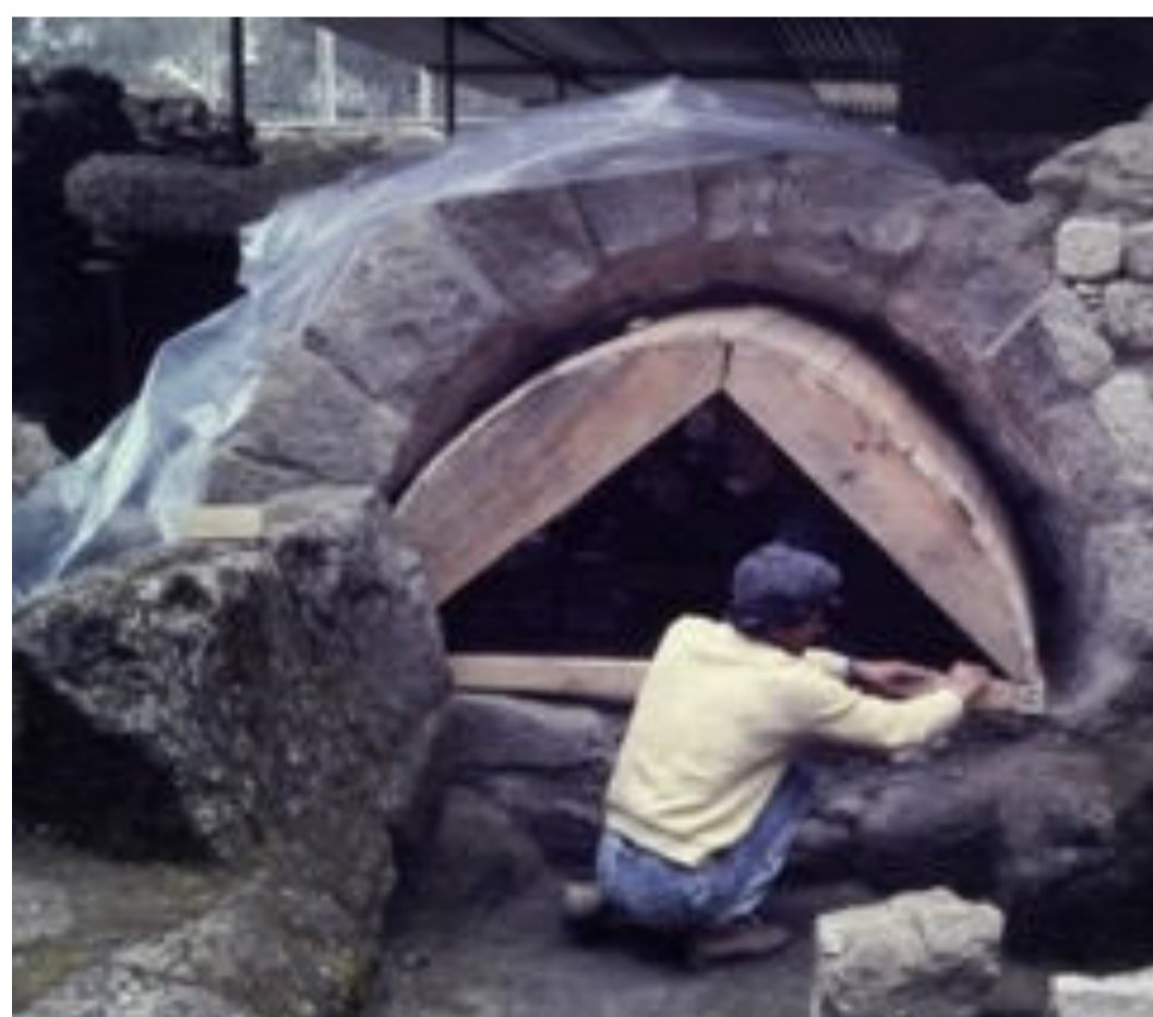
Fig. 3 Restauración de una de las bóvedas de los baños (de Tongobriga), entre 1988 y 1989. Archivo personal de Vítor Hugo Torres ©.
