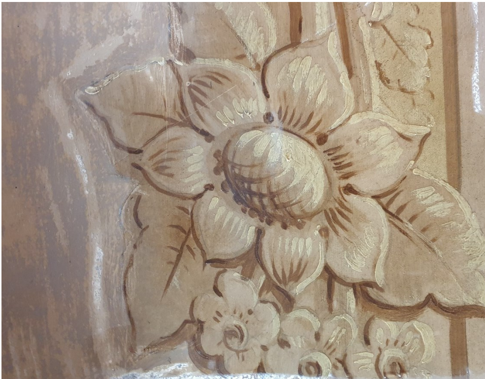
Figura AP III – A103 - Exemplos da 1ª fase de limpeza com água destilada. Cíntia Freitas©
