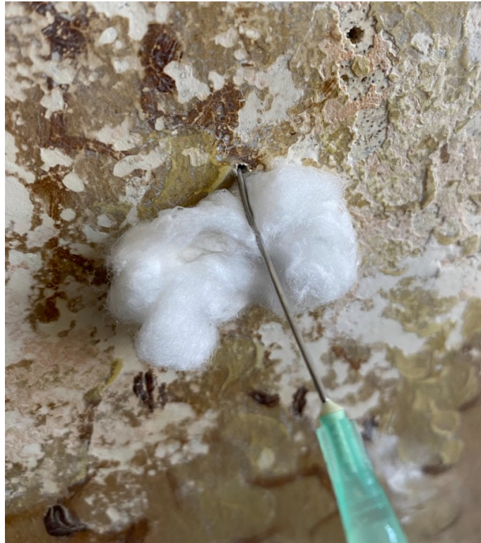
Figura APIII – A111 - Injeção de Primal Ac33 para consolidação da camada de suporte. Cíntia Freitas©
