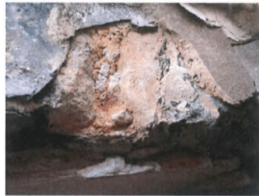
1-Estruturas//1 a) Manta asfáltica.//1 b) Vigamento dos pisos e ripas para fixação do fasquio//1 c) e d) Tesouras reforçadas e pendural de reforço// 1 e) camadas de argamassa do revestimento interior//1.1 b) Rufos metálicos do telhado
