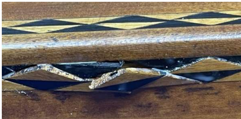
Figura 47 - Encaixe e montagem dos embutidos
