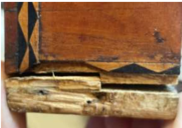
Figura 55 - Fissura entre o fundo e as ilhargas da base da caixa
