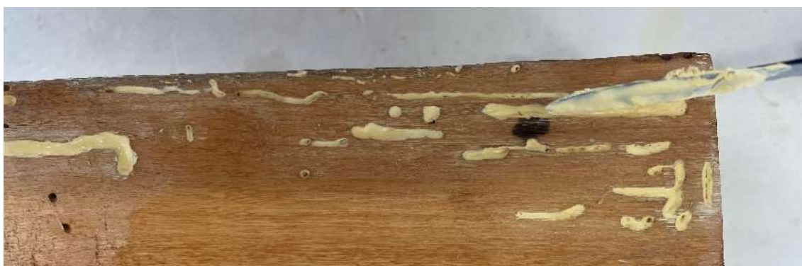
Figura 52 - Aplicação da massa de preenchimento
