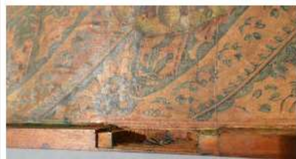
Pormenor do lado do fecho, após colagem do papel destacado
