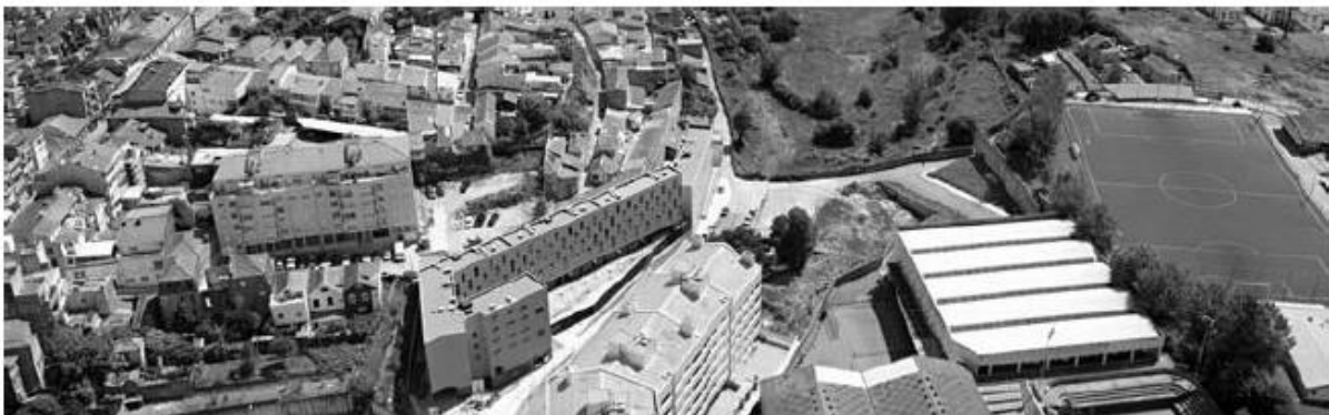
Fig. 43 – foto aérea | Fonte: « http://www.ava-architects.com/salgueiros.html » (adaptada)
