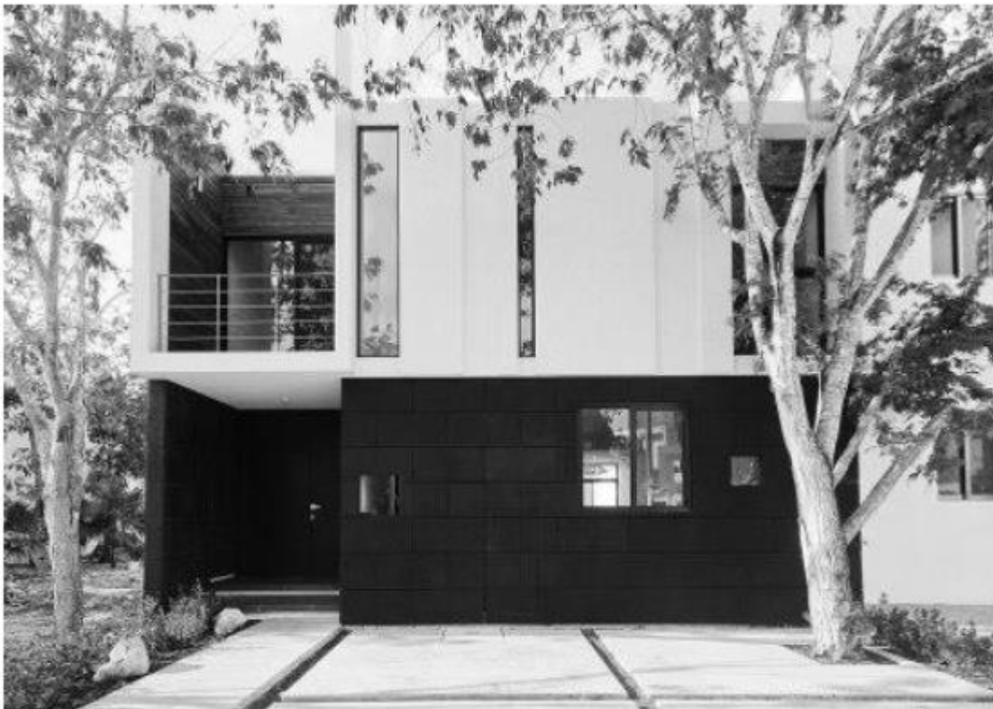
Fig. 45 – fotografia | Fonte: « http://www.arquitour.com/casa-w39-warm-architects/2013/05/ »
