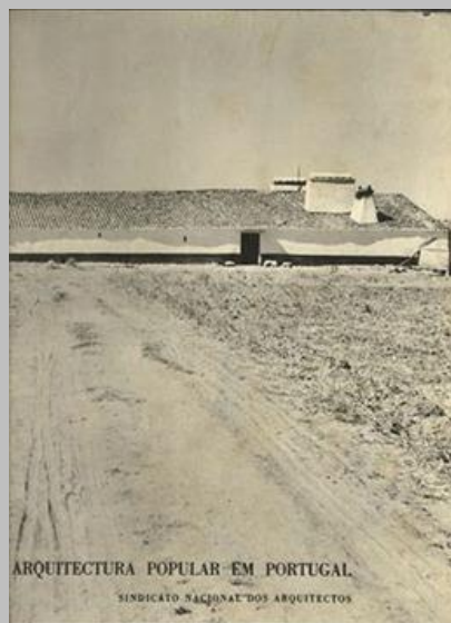
FIGURA 23 - Arquitectura Popular em Portugal Volume 3, Sindicato Nacional dos Arquitectos 1960, Rui Santos 2013
