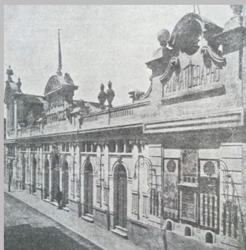
FIGURA 10 – Chiado Terrasse Nova fachada - Lisboa; Anabela Felino 2008
