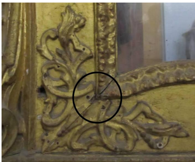
Fig. 4 Destacamento da camada dourada que colocou em evidência elementos metálicos em corrosão.
