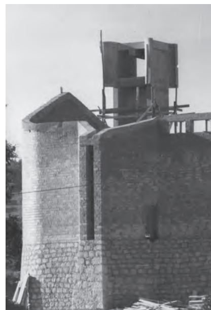
Capela em construção, c.1966 Espólio Diogo Lino Pimentel
