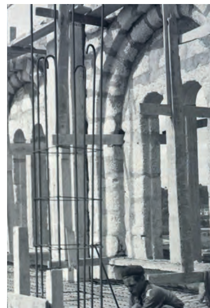
A igreja em construção, c. 1952. Arquivo da Província Portuguesa da Ordem dos Pregadores
