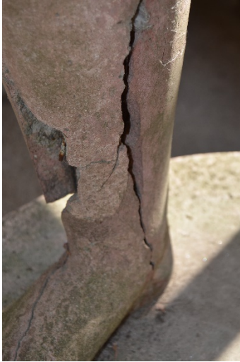
Figura 7 Grieta en pierna derecha de figura masculina.
