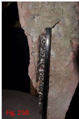
Figura 250 y 251 Unión de vara y hormigón en pierna derecha de la figura femenina.
