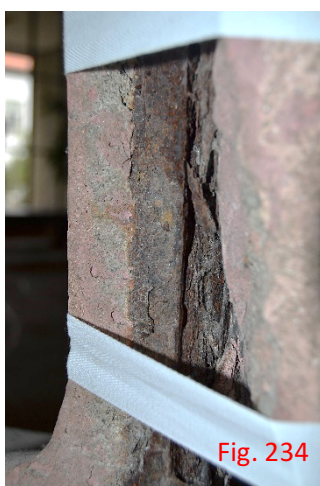
Figura 230, 231, 232, 233 y 234 Estado de conservación de la pierna derecha de la figura femenina. En la Figura 233 se han eliminado los fragmentos desprendidos por la degradación correspondiente al talón. En la Figura 234 se observa en detalle de la degradación del acero de refuerzo de la estructura
