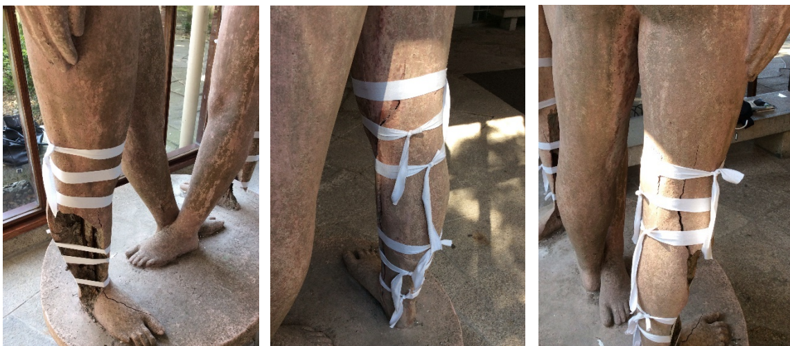
Figura 24 Desprendimiento de gran superficie de sustrato de hormigón en el costado de la pierna derecha de la figura masculina.
