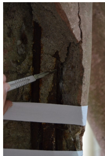
Figura 33 Pierna derecha de figura masculina. Muestra 3, acero de sustento.
