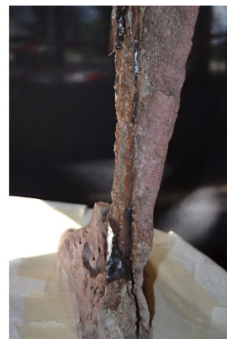
Figura 247 Aspecto de la pierna derecha de la figura femenina después del colapso del acero corroído y posterior limpieza y protección de la zona.
