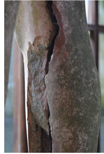
Figura 12 Sustrato en peligro de desprendimiento en pierna derecha de figura femenina.
