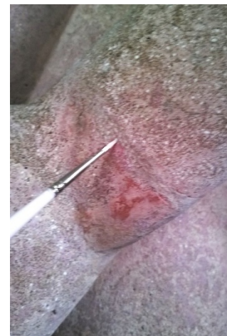
Figura 275 Reintegración por puntos con guache y acuarela para igualar la superficie reintegrada con la original.
