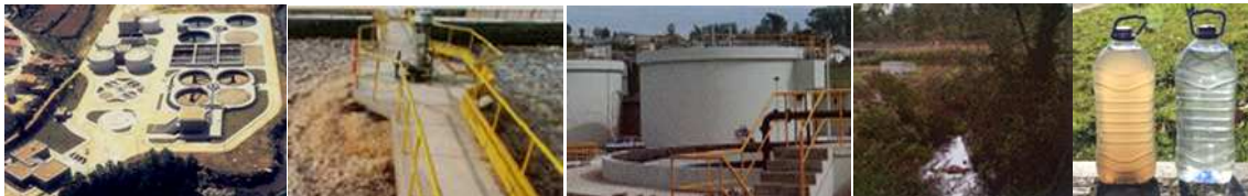
Figura 1. Vista geral da ETAR, tanques de tratamento biológico, ribeira adjacente à ETAR onde é descarregado o efluente tratado e aspeto das amostras de águas antes e após o tratamento.
